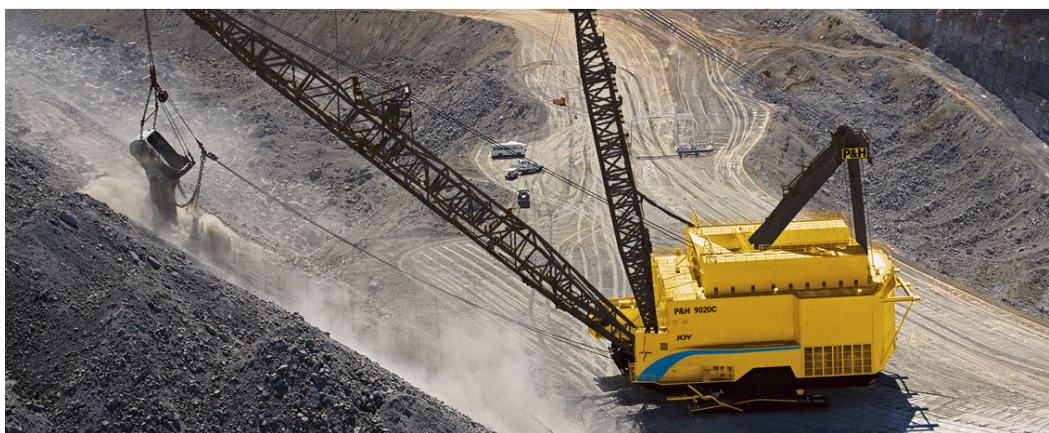
Figura 3.37 – Escavação mecânica por meio de draglines (JOYGLOBAL, 2015).
