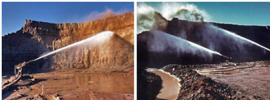
Figura 3.36 – Desmonte hidráulico pela face em barragens na cidade de Kalgoorlie, Austrália (TALINGS.INFO, 2014).
