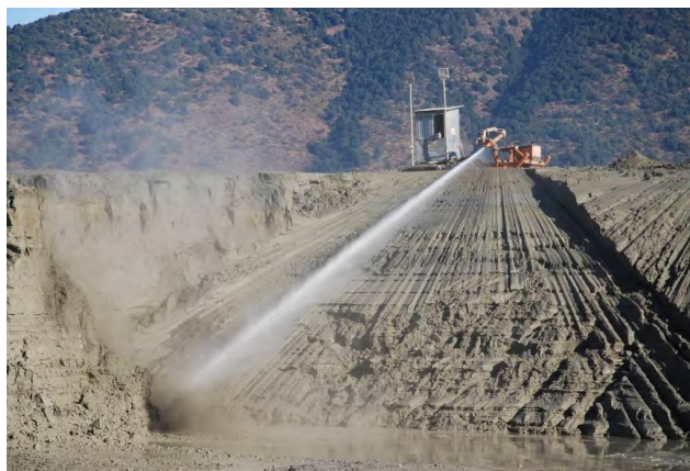
Figura 3.33 – Desmonte hidráulico na Barragem Colihues (HENDERSON, 2013).
