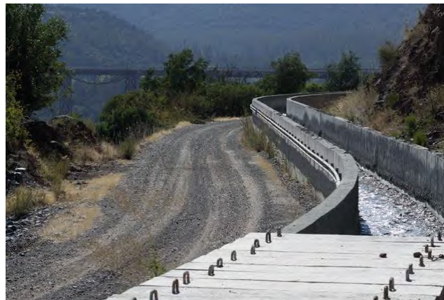
Figura 3.32 – Canal para transporte de rejeitos da Usina de El Teniente (HENDERSON, 2013).
