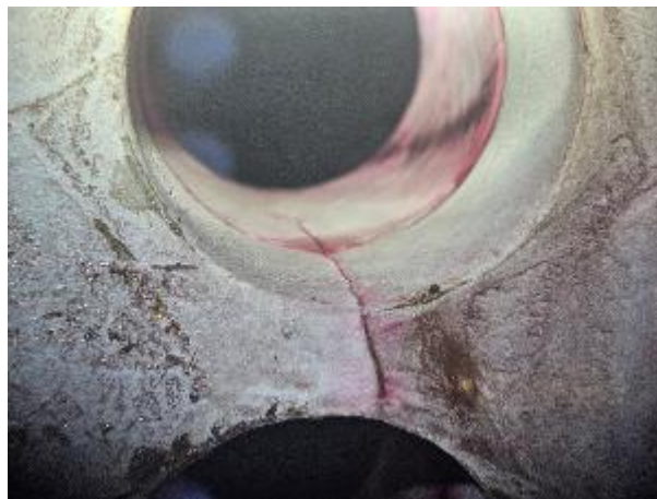
Figura 5 – Detalhe da trinca entre os orifícios 15 e 16.
