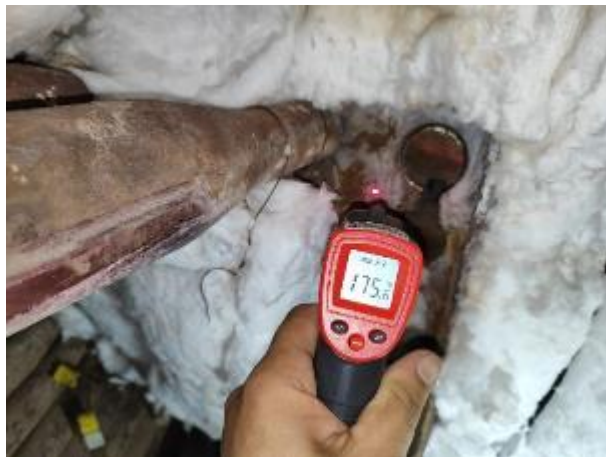
Figura 11 - Pré-aquecimento a 175 °C por meio de resistência elétrica
