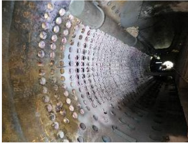
Figura 2 – Aplicação de revelador em parte dos tubos do banco.
