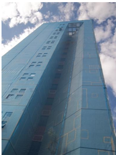
Foto 05 – Proteção da edificação Fonte: Autora
