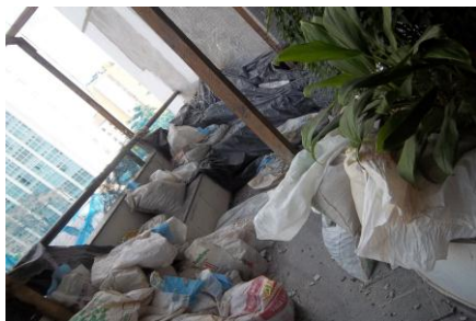
Foto 25 – Resíduo na obra Fonte: Autora
