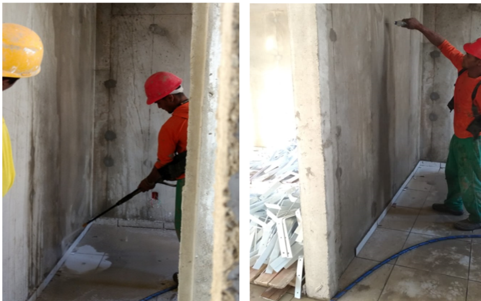
Figura 10:Exemplos de procedimentos de limpeza com hidrojateamento e escovação. Fonte: arquivo do autor.
