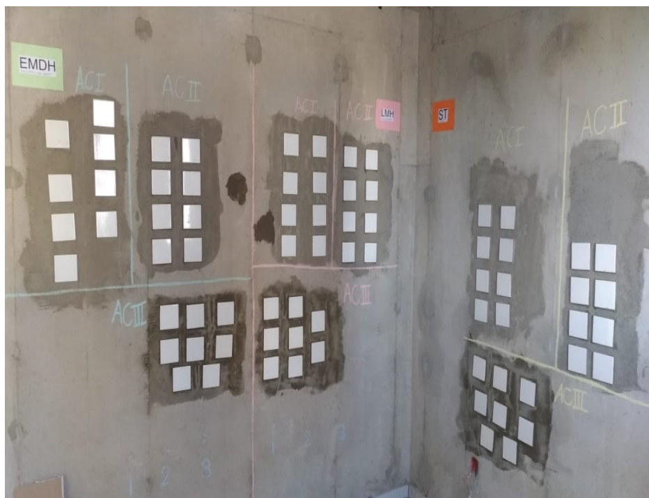
Figura 15: Painéis utilizados nos ensaios de arrancamento. Fonte: arquivo do autor
