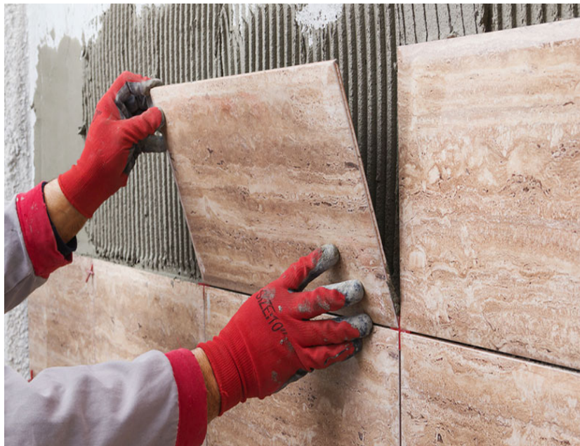
Figura 6: Assentamento de revestimento cerâmico com argamassa colante. Fonte: https://www.mapadaobra.com.br/capacitacao/dicas-para-fazer-o-acabamento-de-parede-com-qualidade/
