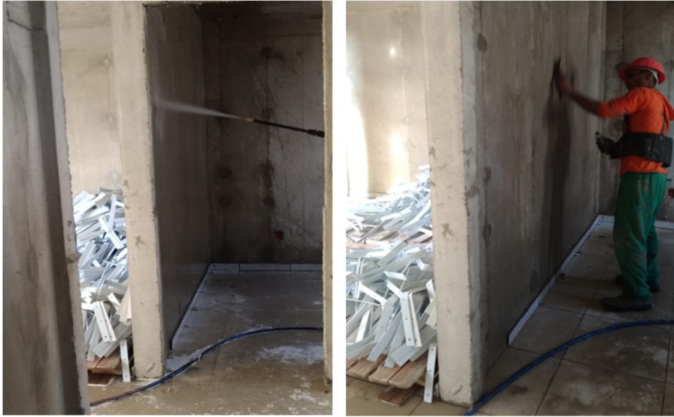
Figura 11:Exemplos de procedimentos de limpeza com hidrojateamento e lixamento. Fonte: arquivo do autor
