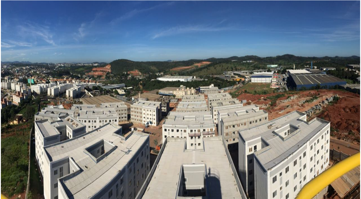
Figura 2: Vista geral de uma obra MINHA CASA MINHA VIDA. Fonte: arquivo do Autor
