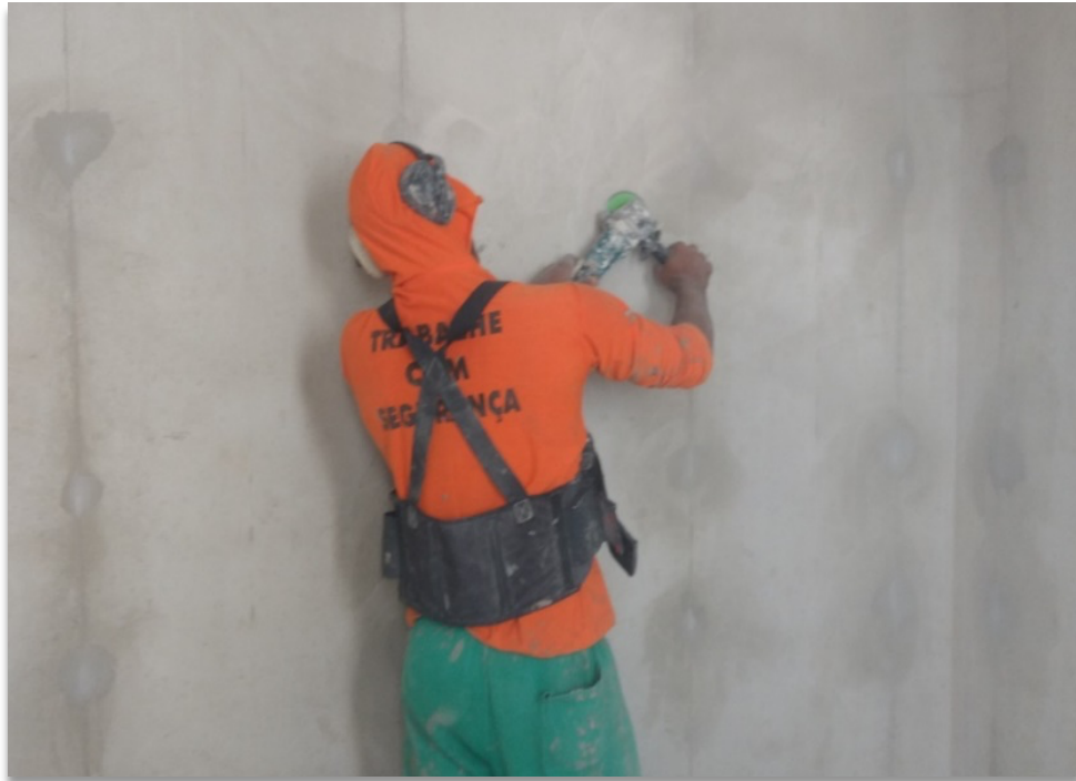
Figura 13: Exemplo de procedimento de limpeza com esmerilhadeira elétrica. Fonte: arquivo do autor
