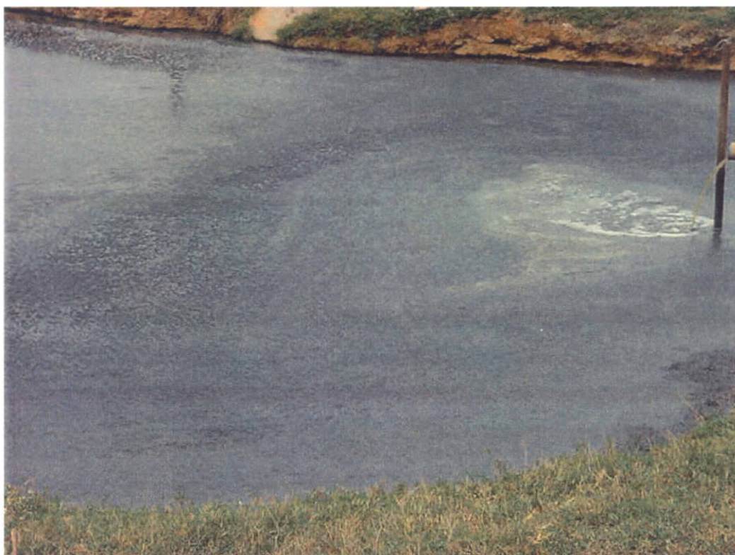
Figura 3 – Vista lateral da lagoa anaeróbia: detalhe do assoreamento lateral.
