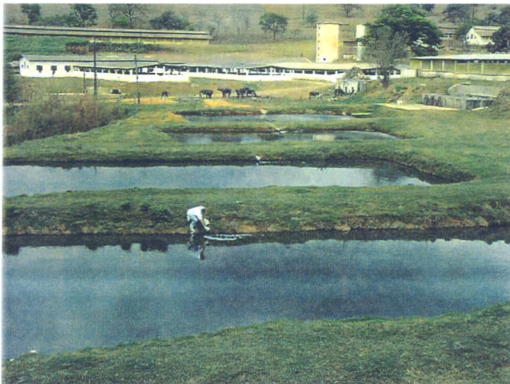
Figura 01- Vista geral do sistema com gradeadores e lagoas seriadas.
