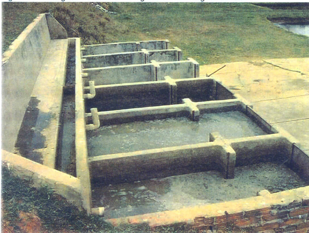
Figura 2 – Detalhamento dos gradeadores após higienização das baias.
