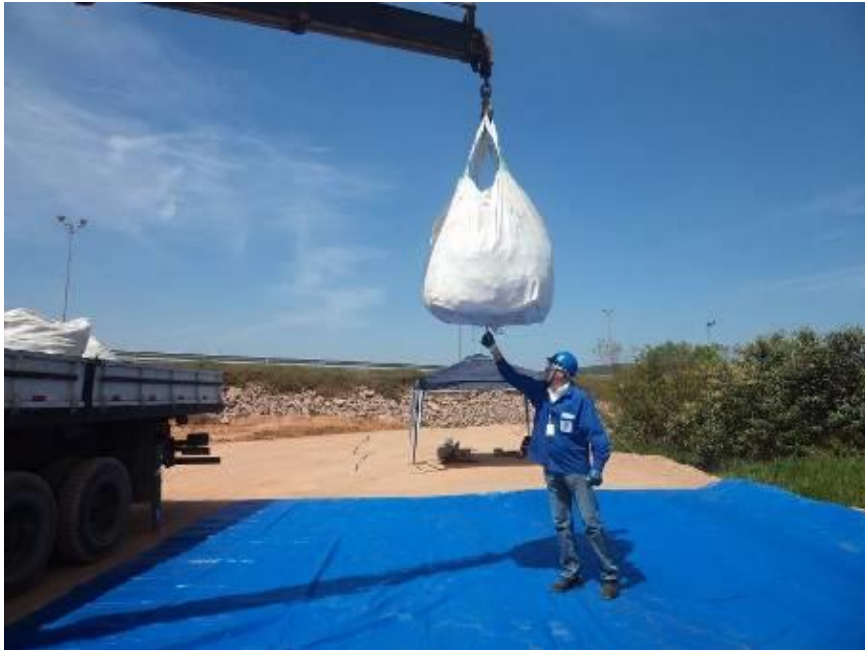
FIGURA 3.2 – Içamento dos sacos pelo caminhão Munck para simulação da formação da pilha de estoque.
