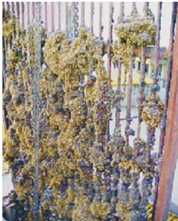
Figura 3.25 – Mexilhão dourado na captação da ETA
