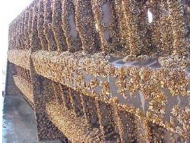
Figura 3.17 – Mexilhões em sistemas de água bruta em hidrelétrica
