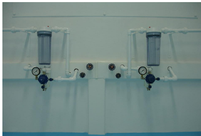
Figura 4.3 – Sistema de água desclorada
