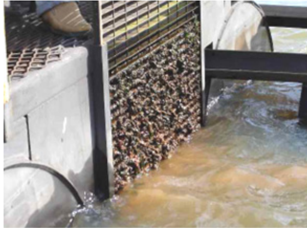
Figura 3.25 – Mexilhão dourado na captação da ETA
