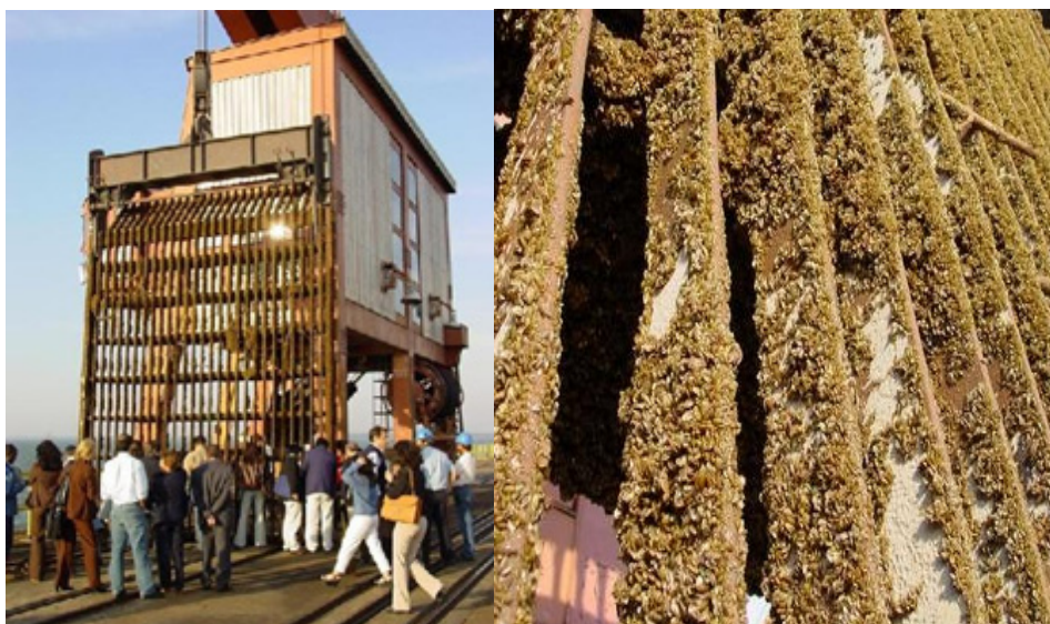
Figura 3.23 – Grade de proteção de Usina Hidrelétrica incrustada de L. fortunei , como observado no detalhe à direita
