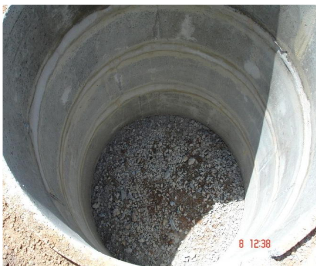
Figura 4.4 – Caixa de infiltração no solo
