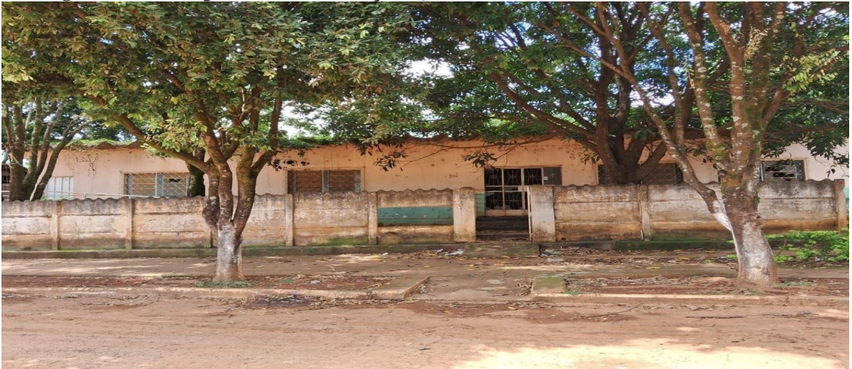
Figura 11 – Foto prédio da Associação Quilombola da Pontinha antes da reforma
