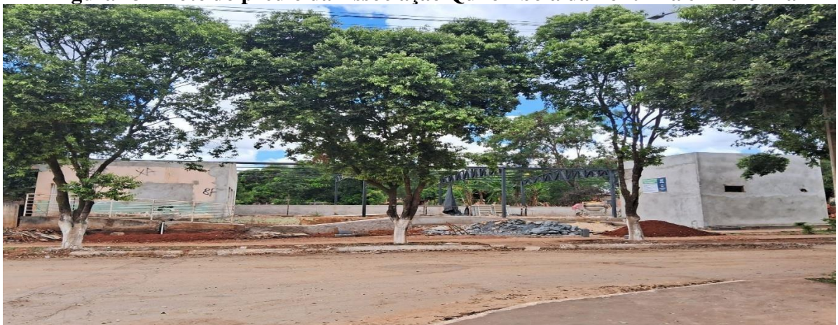
Figura 13 – Foto do prédio da Associação Quilombola da Pontinha em reforma
