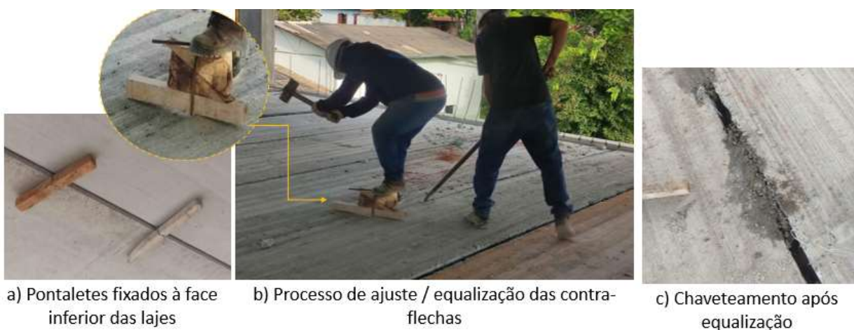
Figura 93 – Processo de equalização de lajes
