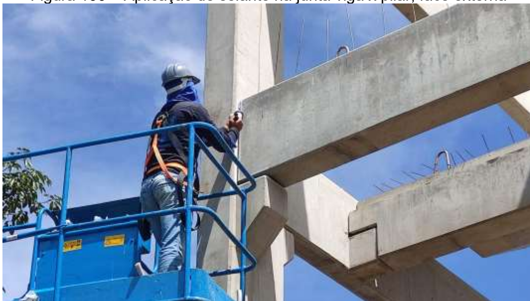
Figura 100 – Aplicação de selante na junta viga x pilar, face externa
