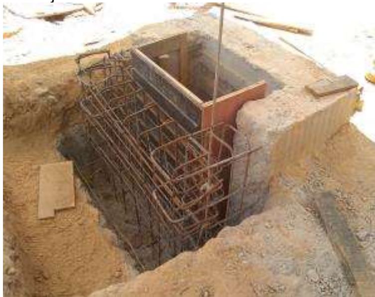
Figura 51 – Ajuste do cálice do bloco com refazimento da armação
