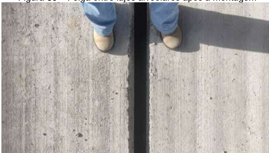
Figura 86 – Folga entre lajes alveolares após a montagem
