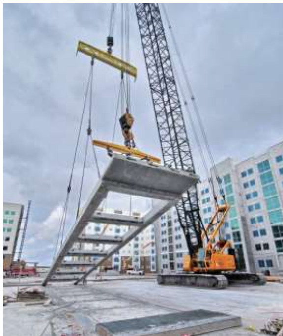
Figura 2 – Içamento de painel pré-moldado.
