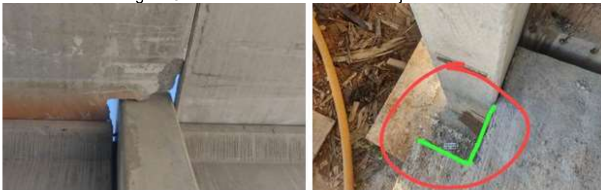
Figura 87 – Detalhe de aberturas em lajes de canto
