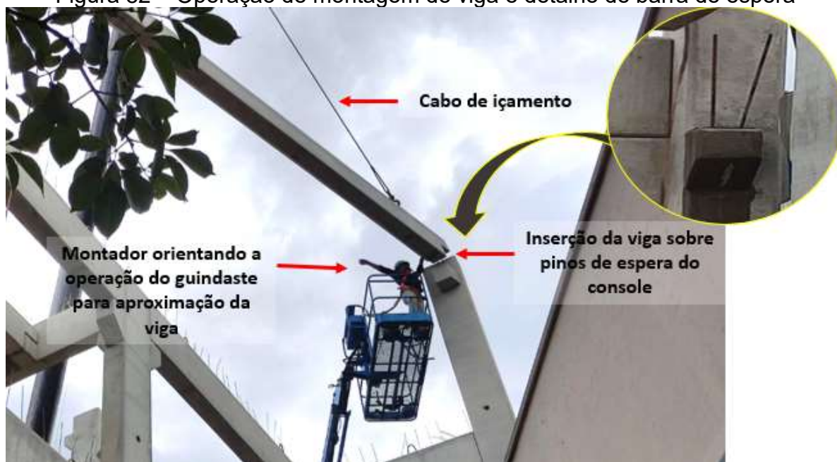
Figura 82 – Operação de montagem de viga e detalhe de barra de espera
