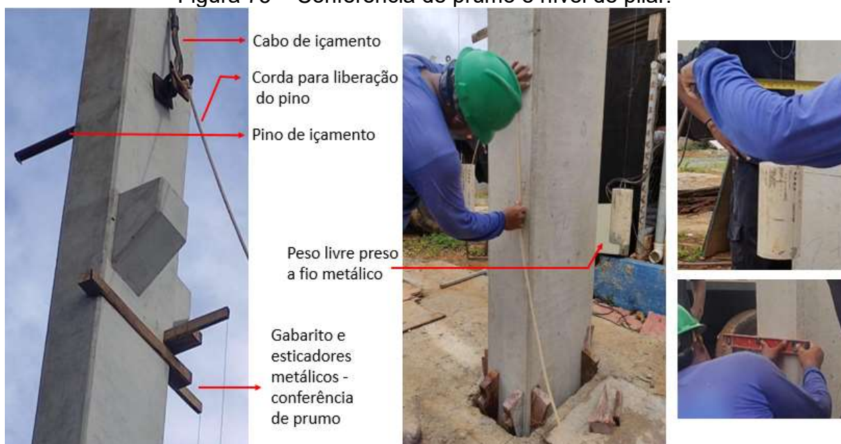
Figura 75 – Conferência de prumo e nível de pilar.
