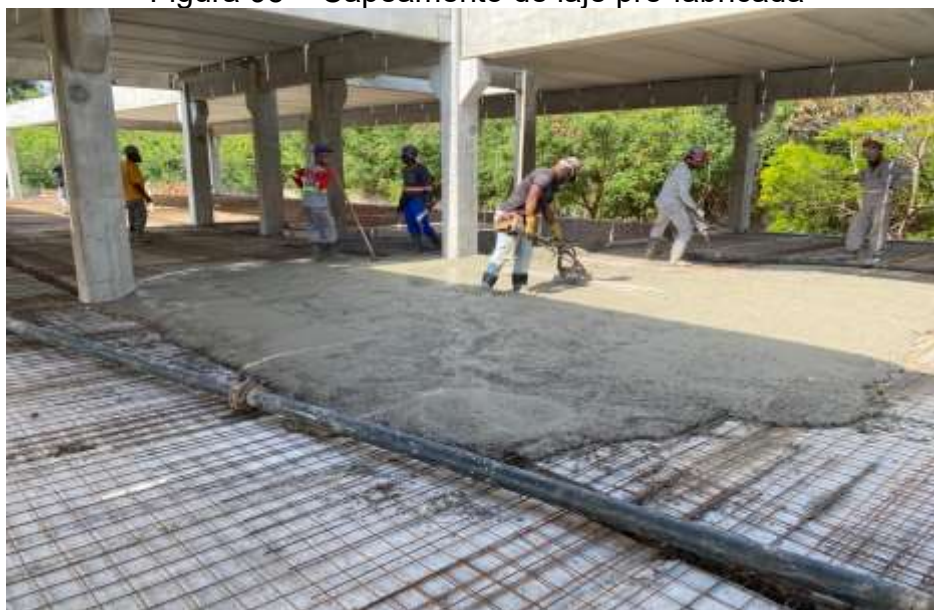
Figura 95 – Capeamento de laje pré-fabricada
