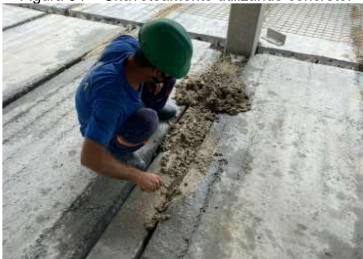
Figura 94 – Chaveteamento utilizando concreto.
