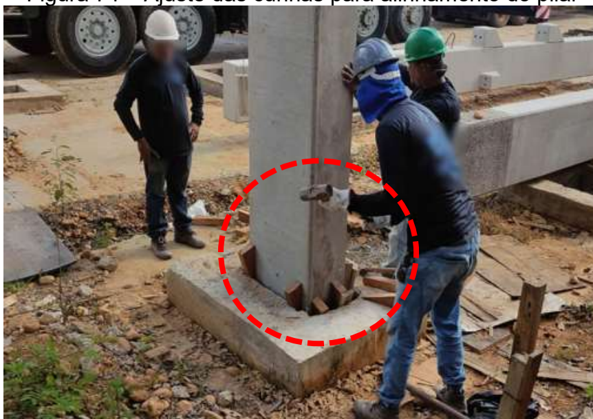
Figura 75 – Conferência de prumo e nível de pilar.
