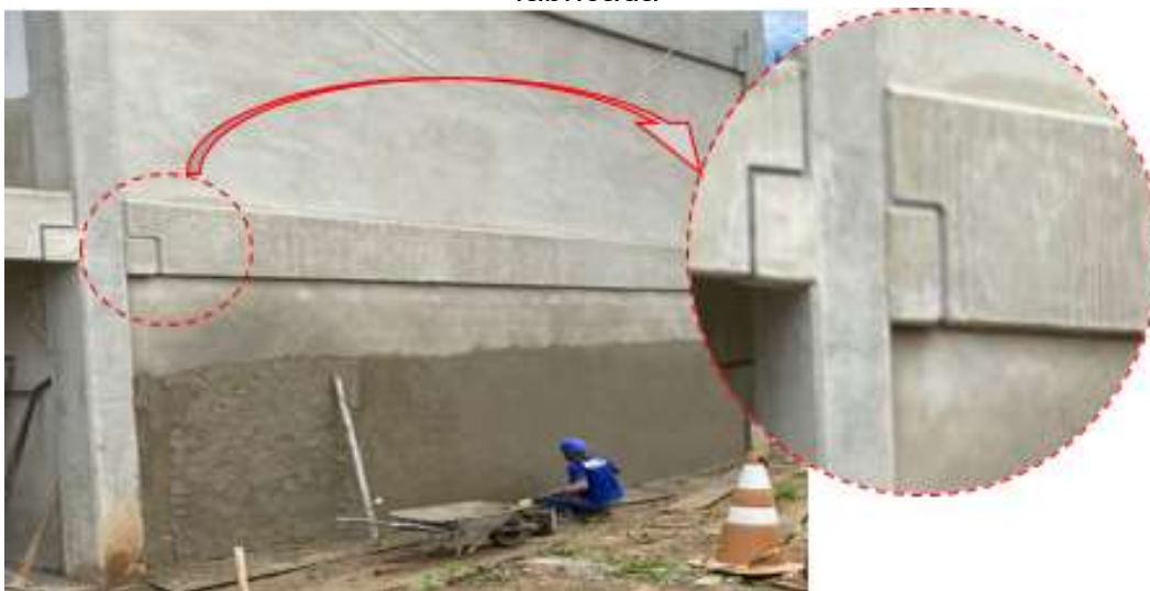
Figura 96 – Detalhe do posicionamento da alvenaria na face externa da viga pré-fabricada
