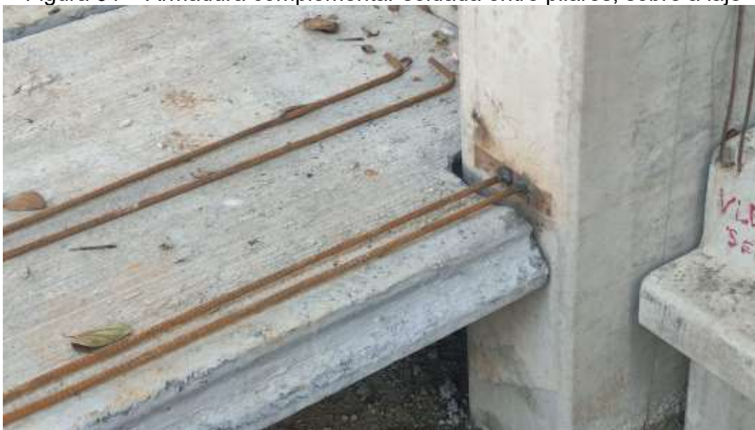
Figura 91 – Armadura complementar soldada entre pilares, sobre a laje
