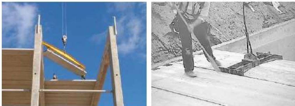
- a) Montagem de laje alveolar com balancim e cinta - b) Montagem com garras
