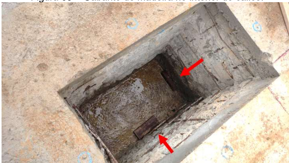
Figura 65 – Gabarito de madeira no interior do cálice.
