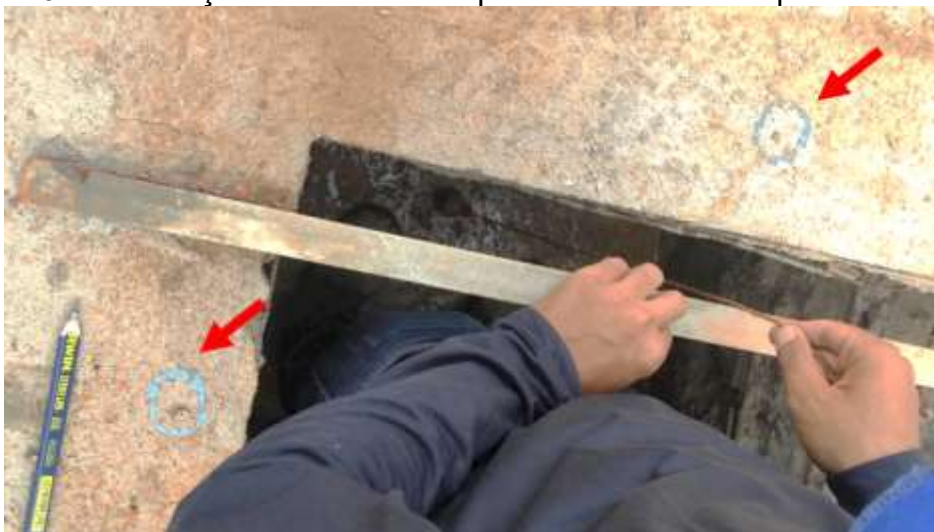
Figura 64 – Marcação das laterais do pilar e no fundo com prumo de centro
