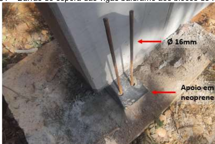
Figura 81 – Barras de espera das vigas baldrame aos blocos de fundação
