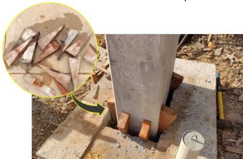
Figura 73 – Cunhas de madeira colocadas nas quatro faces do pilar
