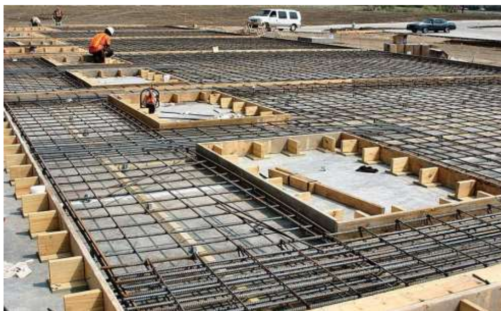
Figura 1 - Exemplo de painéis de concreto em produção no canteiro de obras
