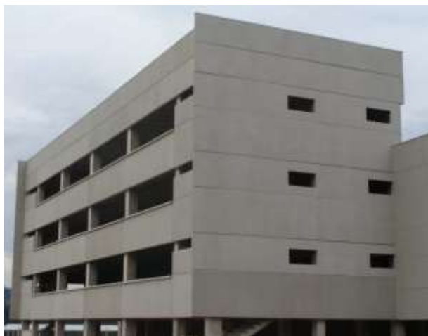
Figura 5 – Exemplo de edifício em painéis de concreto pré-fabricado
