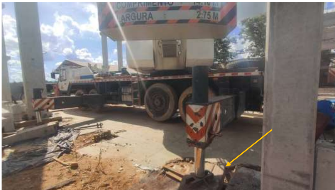
Figura 58 – Carreta estabilizada ao solo.
