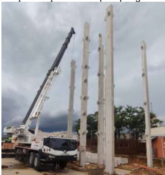
Figura 59 – Operação de içamento de pilar por guindaste sobre rodas
