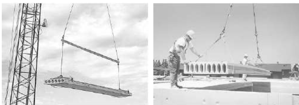
- c) Montagem com garras e alça de segurança - d) Montagem com cabos e laço tipo choker
