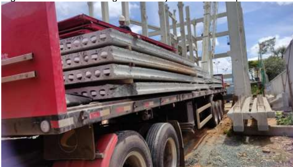
Figura 57 – Carreta carregada com lajes da estrutura pré-fabricada.
