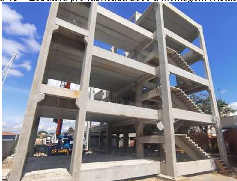
Figura 46 – Estrutura pré-fabricada após a montagem (vistas 1 e 2)
