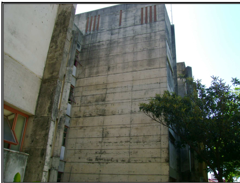
FIGURA 15 - Parede e pilar de concreto aparente.
