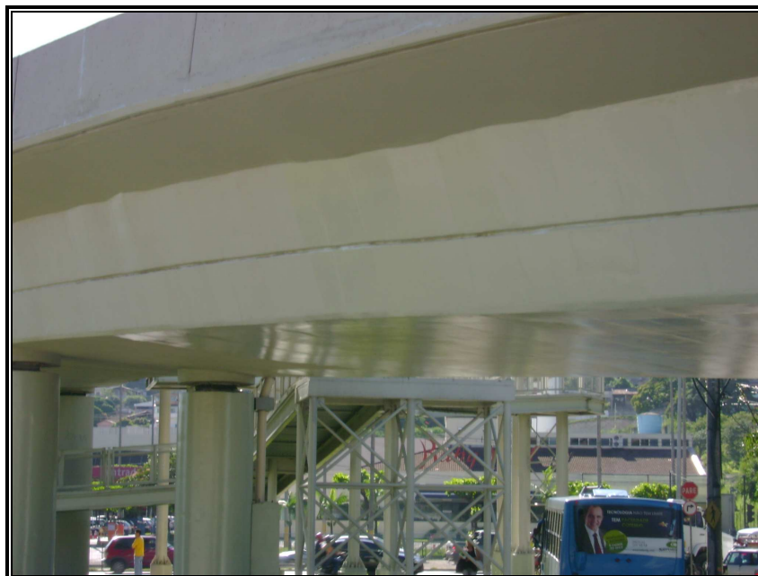
FIGURA 20 - Viaduto com superfície pintada.
