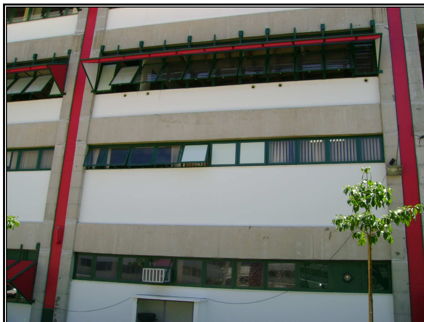
FIGURA 21- Estrutura após tratamento superficial.
