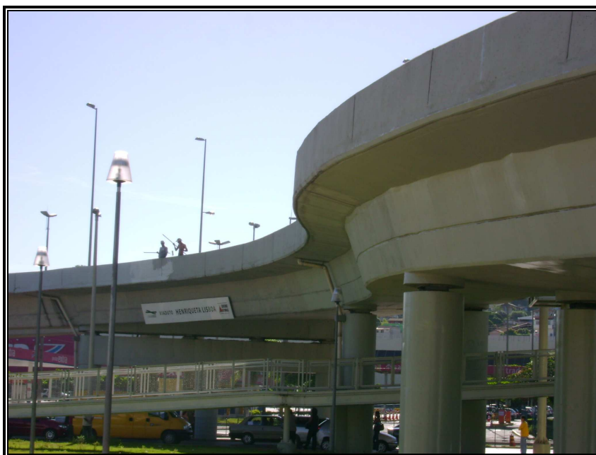
FIGURA 19 - Aplicação de proteção superficial.
