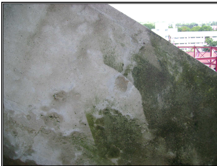
FIGURA 17 - Limpeza de parede de concreto.
