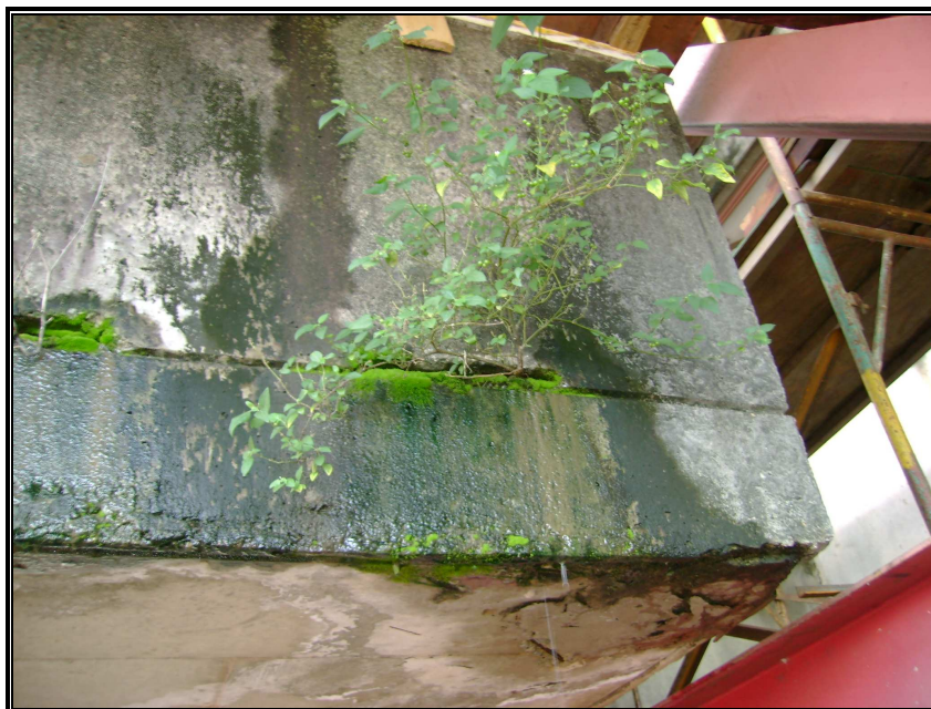
FIGURA 09 - Estrutura em concreto aparente de escada.
