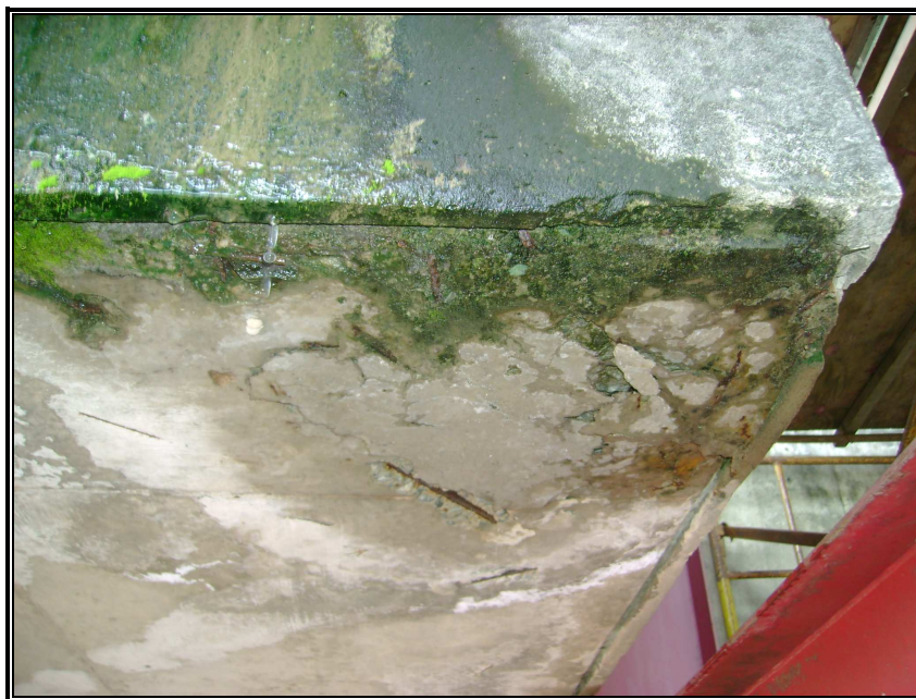
FIGURA 10 - Estrutura em concreto aparente de escada de emergência
