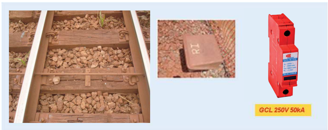
Fig.10.27 - Fotografia DPS GCL 250V 50kA Classe I instalado em caixa de junção próxima ao trilho.
