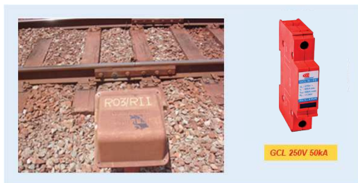
Fig. 10.29 – Fotografia DPS GCL 250V 50kA Classe I, instalado em caixa de junção próxima ao trilho.
