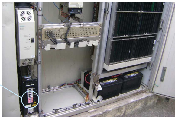
Fig.9.15– Detalhe VCL SP 275V 45kA/SR instalado na linha de energia de um Armário Ótico, para proteção do retificador.
