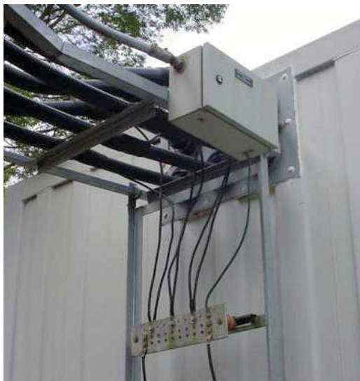
Fig. 9.21 – Aterramento da blindagem de cabos coaxiais.
