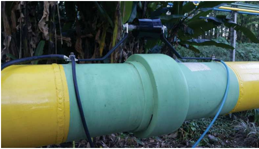
Fig. 10.15 - Proteção de junta isolante ao longo da linha. DPS modelo GCL EC EX
