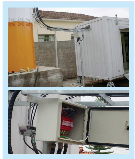
Fig. 9.20 - Detalhe de aplicação de DPS VCL 75V 45kA para proteção de iluminação de balizamento em estação rádio base alimentada em -48Vcc.
