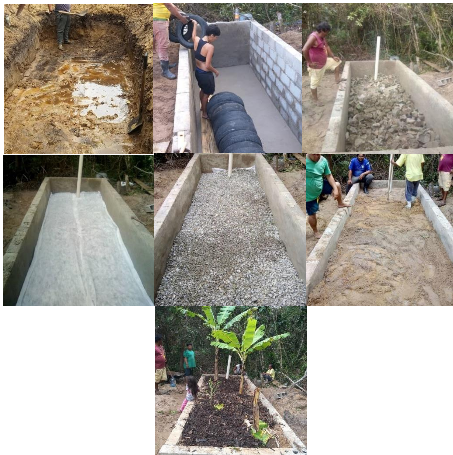
Figura 23: Sequência de construção da Evapotranspiração (BET).
