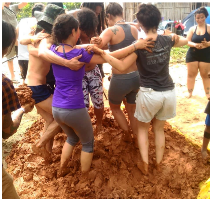
Figura 28: Preparação do barreado.
