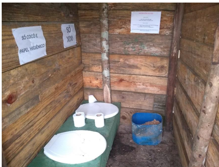
Figura 22: Foto do interior do banheiro seco.
