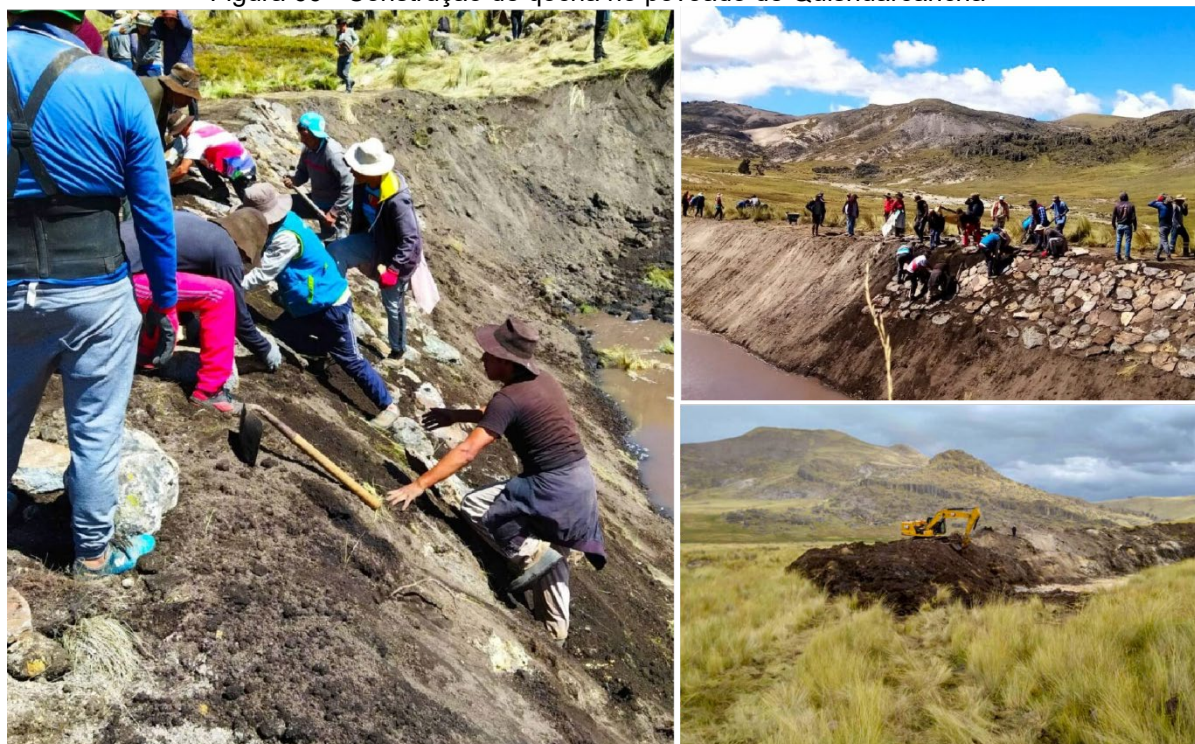
Figura 66 - Construção de qocha no povoado de Quishuarcancha
