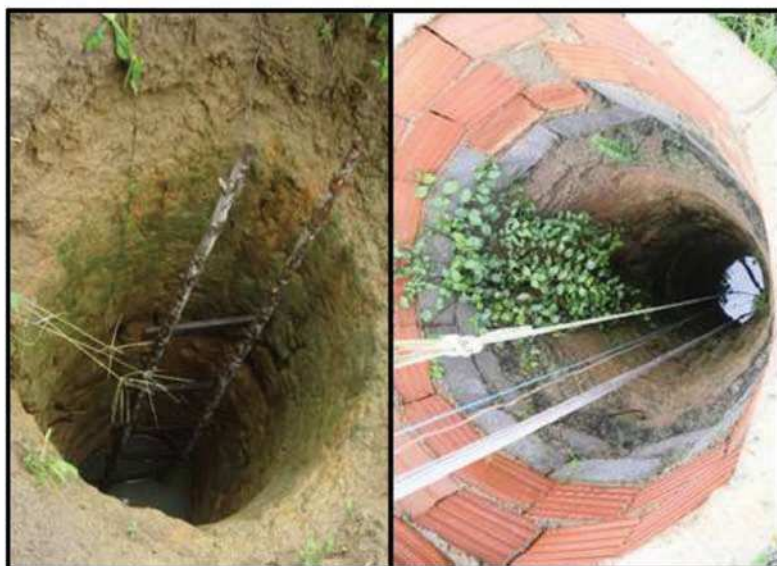
Figura 5: Poços rasos com estruturas precárias
