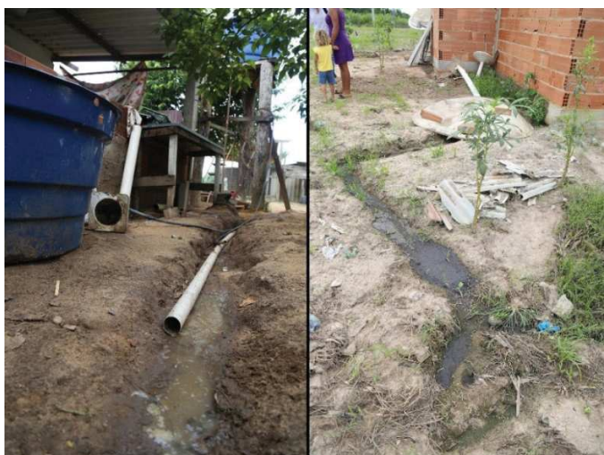
Figura 7: Disposição de águas cinzas em quintal, sem qualquer proteção (E); Extravasamento de efluente de fossa (D)
