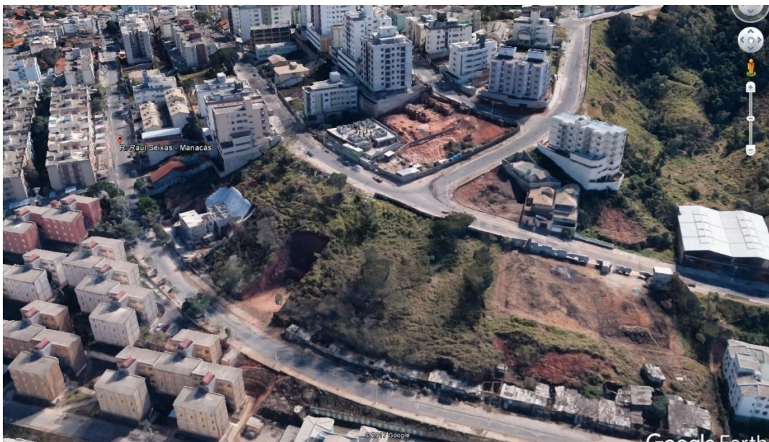
FIGURA 3 - Vista panorâmica da Rua Raul Seixas. Fonte: Google Earth, 2017.
