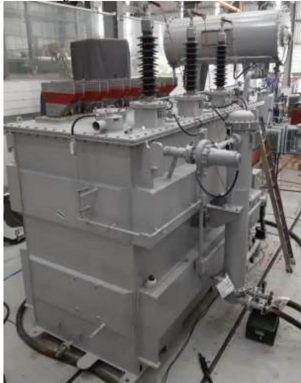
Figura 4.28 – Transformador sob teste.
