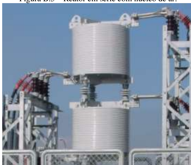
Figura B.5 – Reator em série com núcleo de ar.
