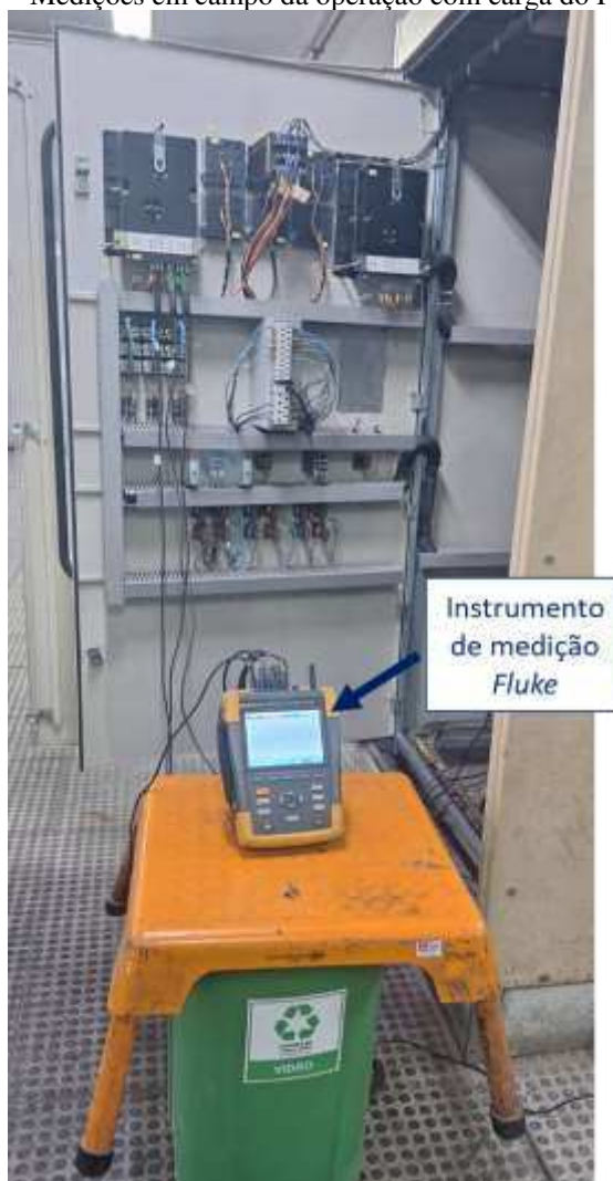
Figura 5.7 – Medições em campo da operação com carga do Forno-Panela.
