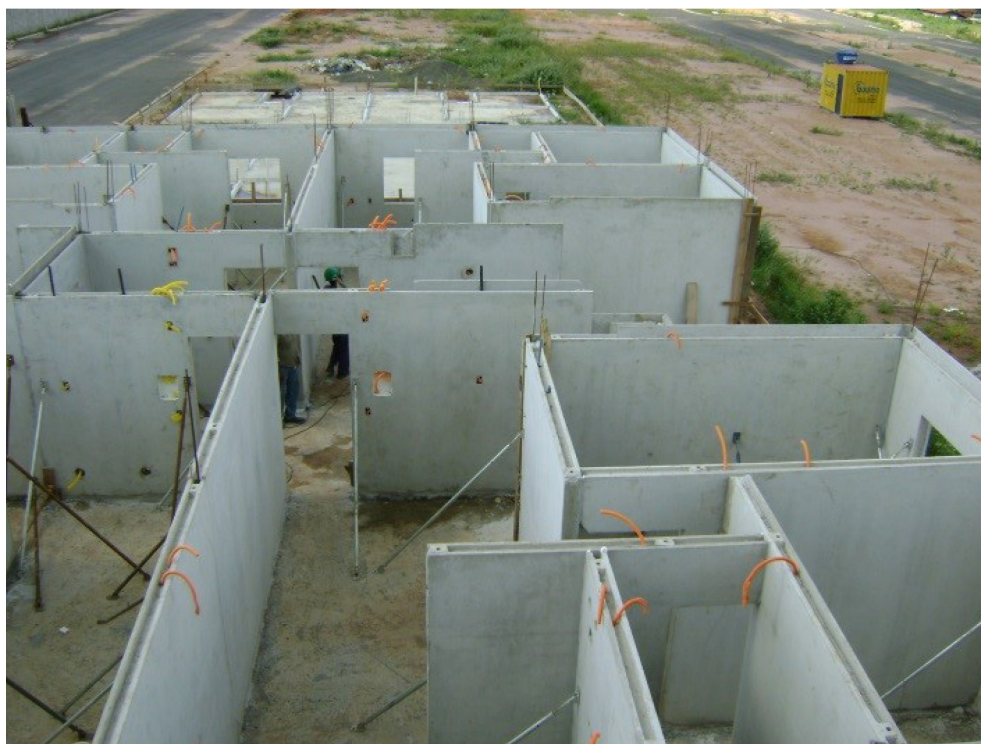
Figura 55-Montagem do Sistema em obra
