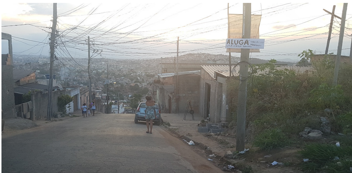
Figura 47 – Rua das Almas, Conjunto Paulo VI – Gatos de energia
