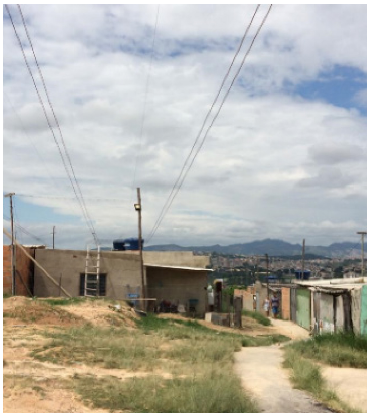
Figura 35 - Vista Conjunto Paulo VI – Ocupação sob linha de alta tensão
