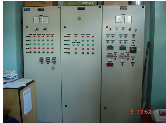
Figura 3.10 – Bombas Dosadoras de Reagentes e Painel de Controle
