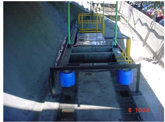
Figura 3.8 – Entrada do Efluente Bruto e Canais Coletores (medidores de vazão)
