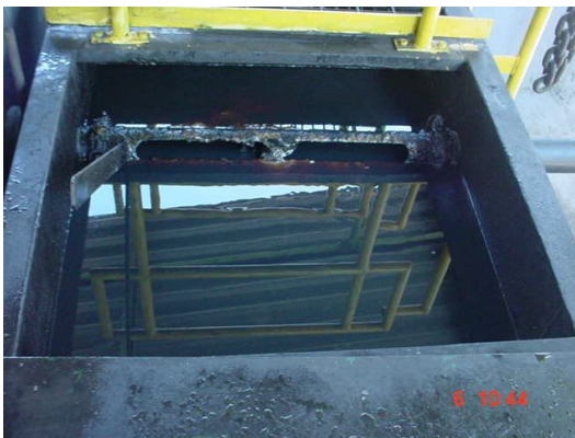
Figura 3.9 – Caixa Separadora Água-Óleo e Tanque Pulmão
