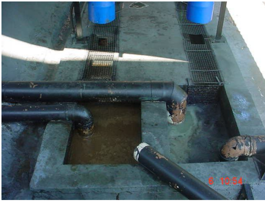
Figura 3.8 – Entrada do Efluente Bruto e Canais Coletores (medidores de vazão)
