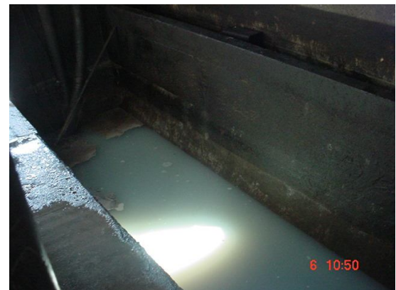
Figura 3.9 – Caixa Separadora Água-Óleo e Tanque Pulmão
