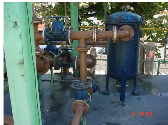
Figura 3.11 – Tanque Tratamento Físico Químico e Filtros
