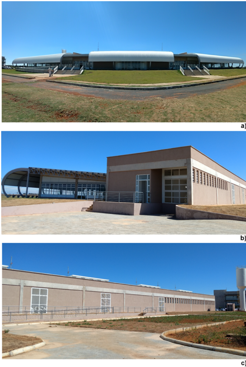
Figura 54 – Prédio do Restaurante Universitário. Ano 2017.
