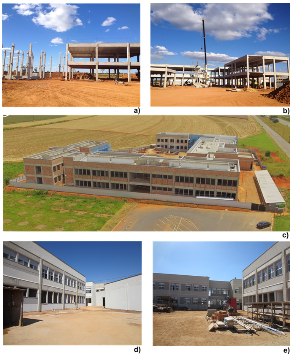
Figura 59 – Prédio de Laboratórios de Ensino: construção.
