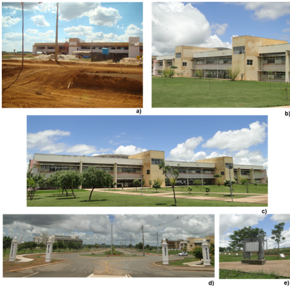
Figura 52 – Prédio Pavilhão de Aulas (PVA)
