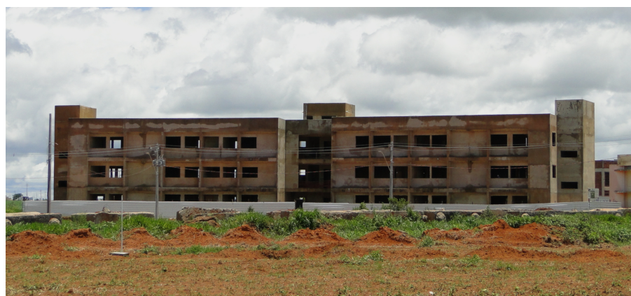
Figura 57 – Prédio Laboratório de Pesquisa. Ano: 2017
