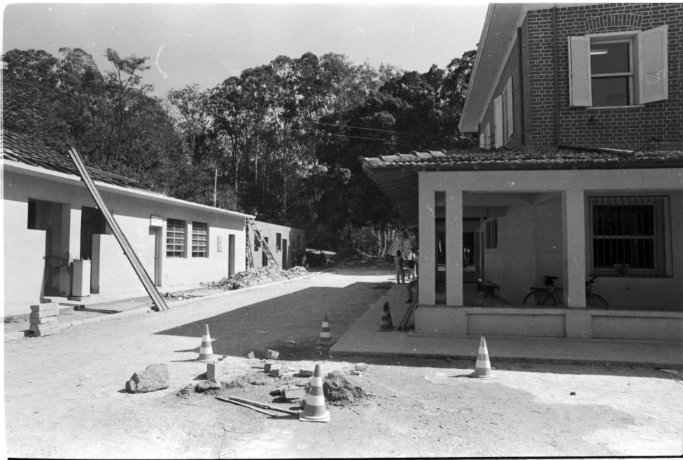
Figura 6: Casarão e anexo em obras para implantação do parque.
