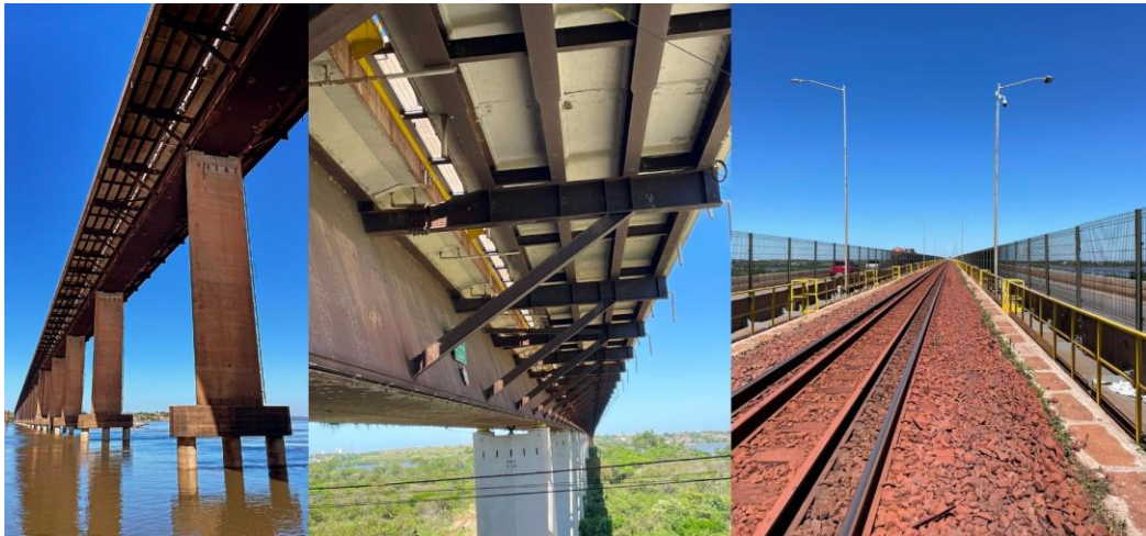
Figura 1.2 – Ponte rodoferroviária em estudo.
