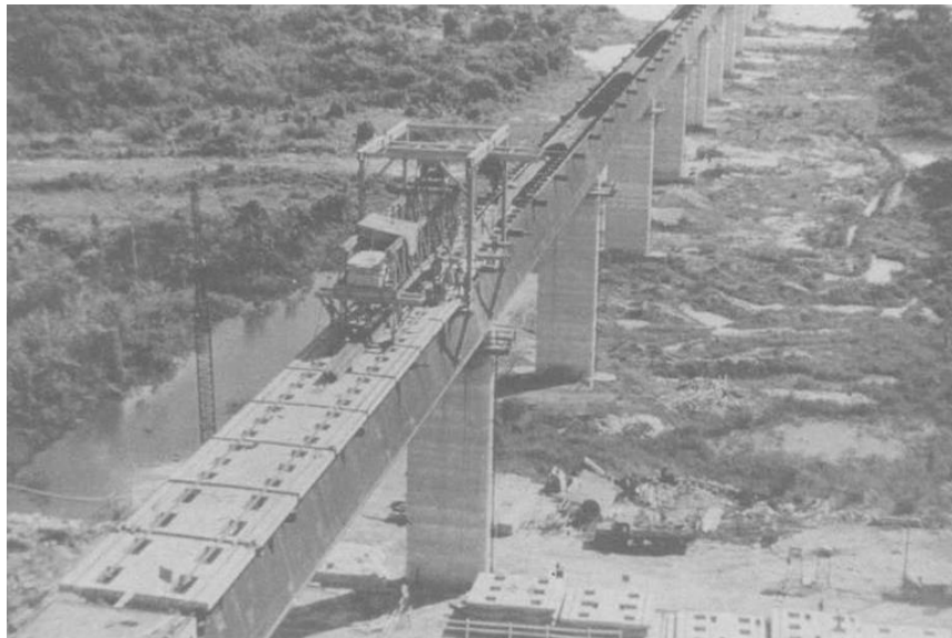
Figura 2.3 – Montagem das placas em concreto armado pré-moldado
