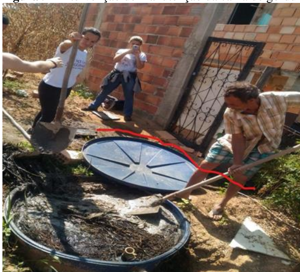
Figura 9 - Intervenção de manutenção da caixa de gordura
