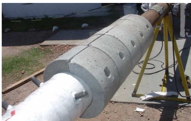
Figura 3.17 - Aplicação das fibras PCW como revestimento isolante de backup.
