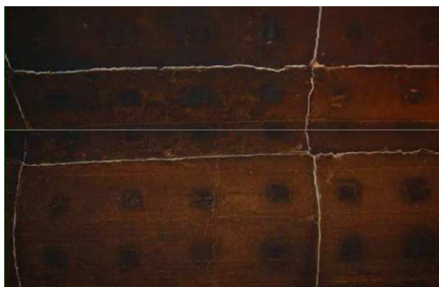
Figura 3.16 – Aplicações das fibras FCR e AES como juntas de expansão.
