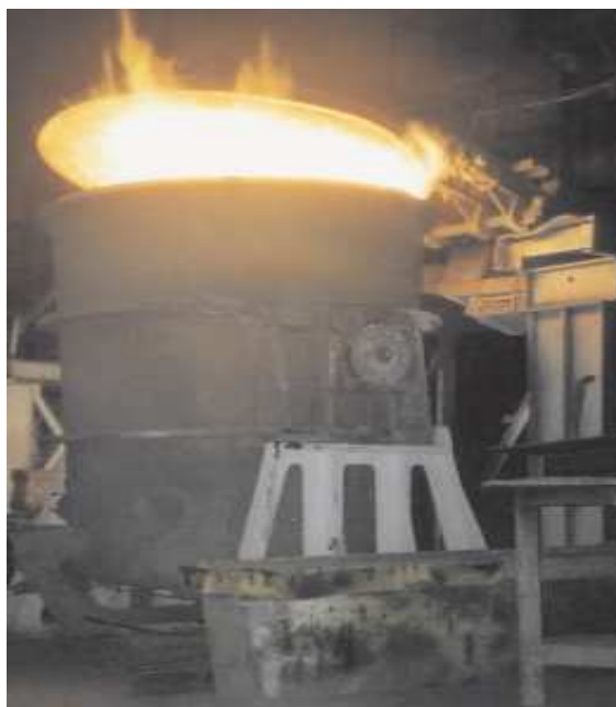
Figura 3.12– Sistema de aquecimento das panelas de aço.
