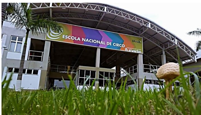
Figura 7 – Imagem recente da fachada da Escola Nacional de Circo, localizada na Praça da Bandeira, no Rio de Janeiro. Fotógrafo não identificado. A instituição conta com uma lona de quatro mastros, além de salas de aula, musculação e fisioterapia, auditório e oficina para confecção e reparo de aparelhos. 25
