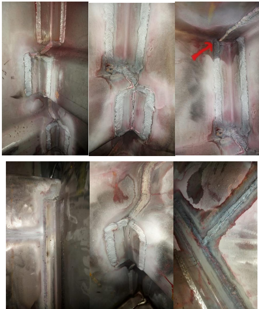
Figura 32 – ensaio LP após procedimento de soldagem.
