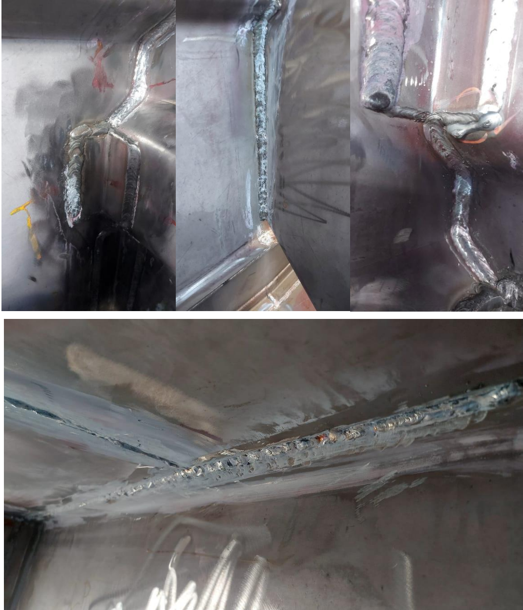
Figura 33 – cordões de solda após aplicação do decapante
