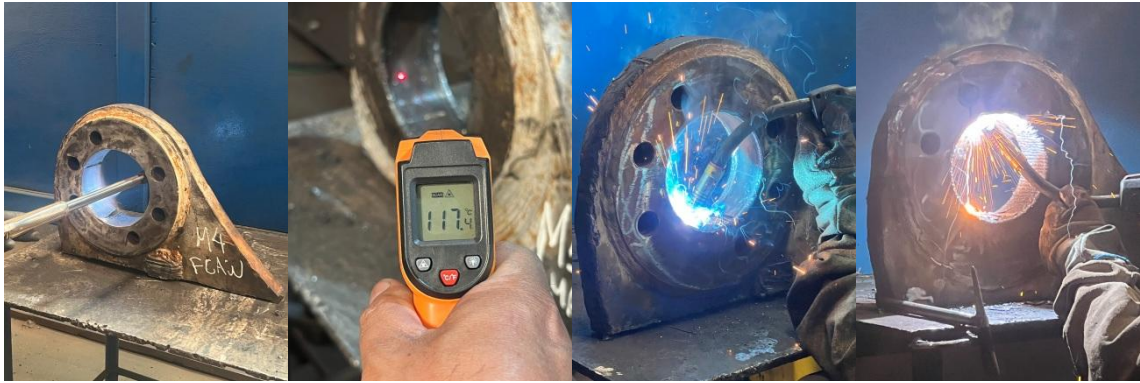
Figura 5. Processo pré-aquecimento e posições de soldagem
