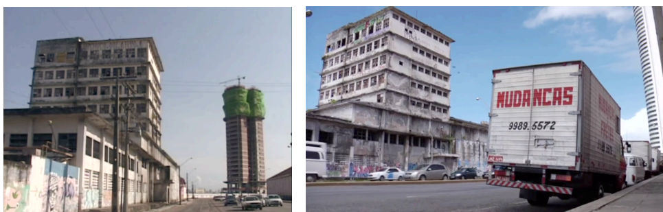
Fig. 125 e 126 – Planos abertos exploram o contraste visual (e os possíveis significados sociais) entre um prédio ocupado e as Torres Gêmeas, na fase de construção e depois de prontas.
