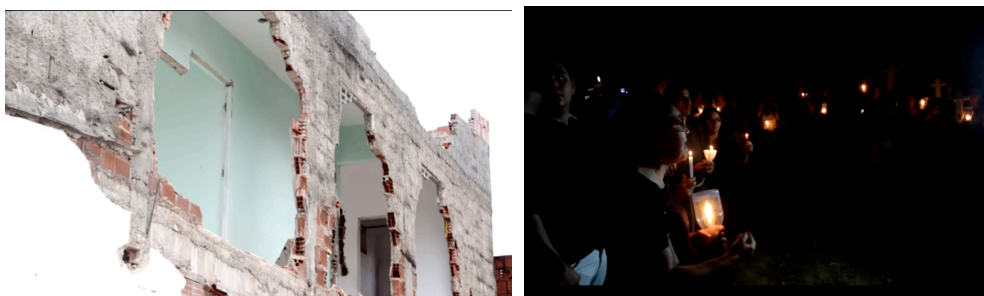
Fig. 141 e 142 – Em Vila Oliveira : ruínas das casas após a demolição conduzida pelos agentes da prefeitura e procissão em apoio às famílias expulsas.
