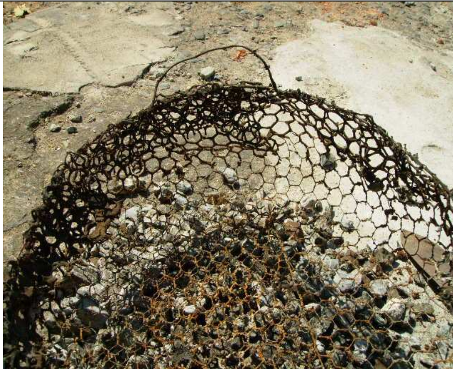
Figura 50 - Características da tela do cesto após a retirada do material drenante. Fonte: José Geraldo de Souza
