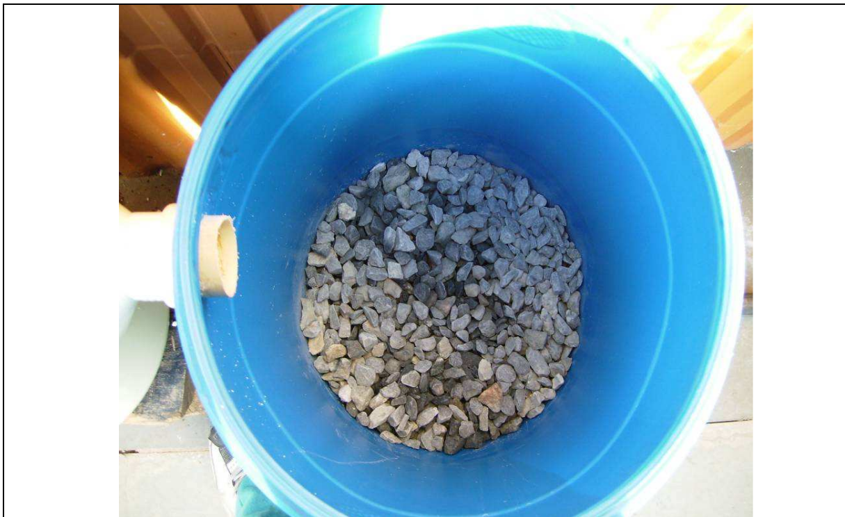
Figura 44 - Lançamento da camada drenante de brita 02, no filtro Fonte: José Geraldo de Souza
