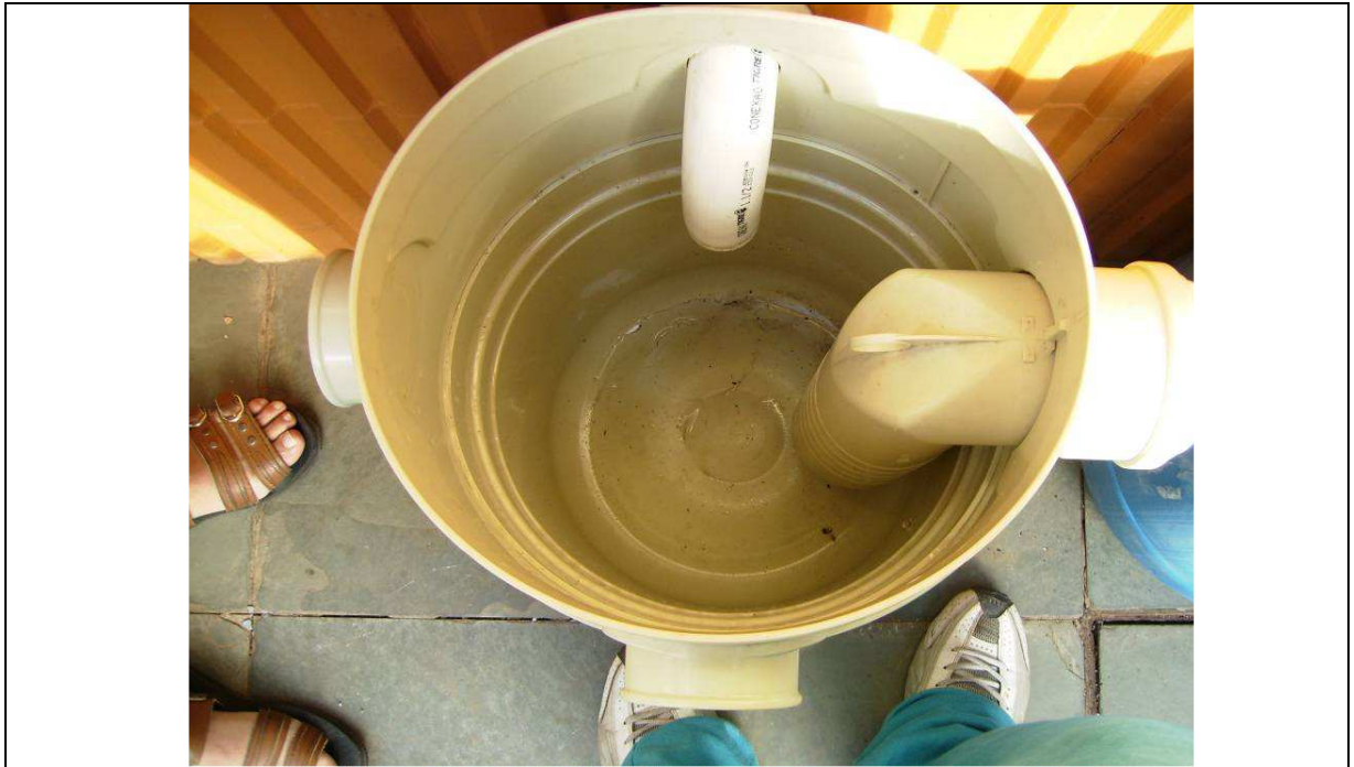
Figura 42 - Instalação da caixa de gordura Fonte: José Geraldo de Souza
