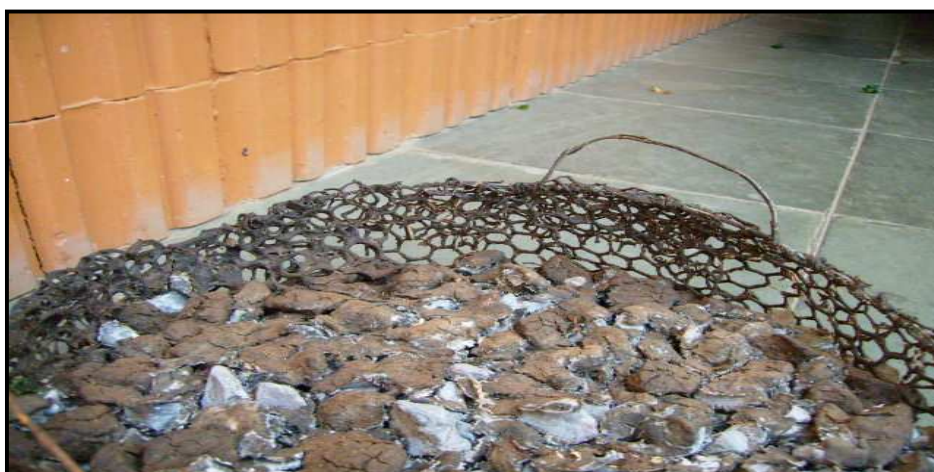
Foto 39: Cesto de tela galvanizada, com camada drenante de brita 01.
