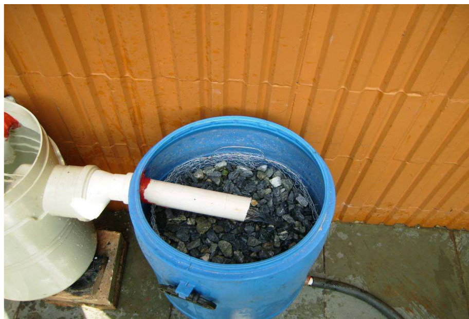
Figura 47 - Filtro montado e em funcionamento com a última camada envolvida pelo cesto de tela galvanizada Fonte: José Geraldo de Souza
