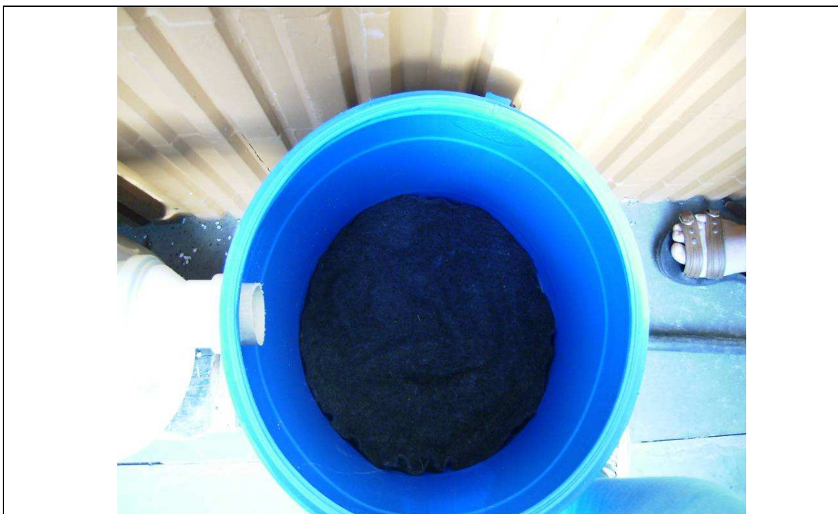
Figura 45 - Colocação da manta geotêxtil entre a camada drenante e a próxima camada de areia. Fonte: José Geraldo de Souza
