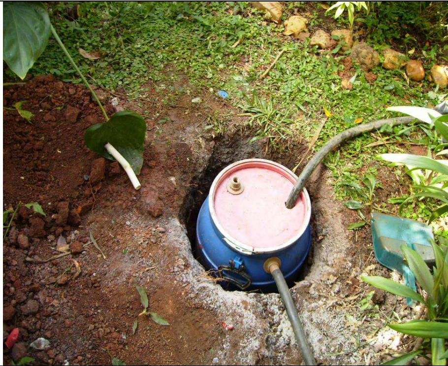
Figura 48 - Instalação do reservatório.
