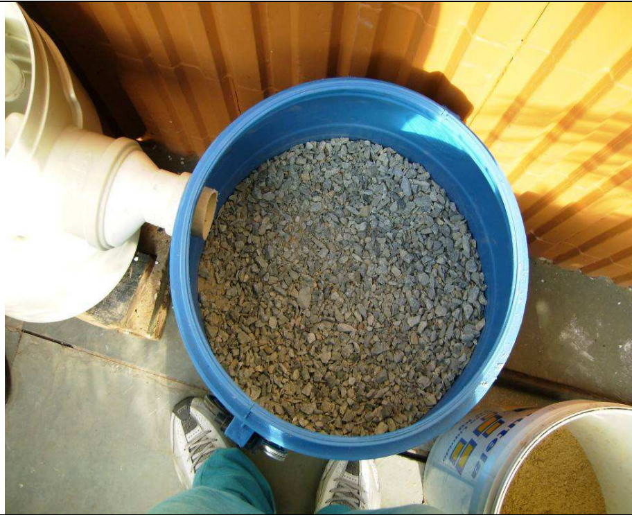
Figura 46 - Cobertura da camada de areia para apoiar o cesto de tela com brita. Fonte: José Geraldo de Souza
