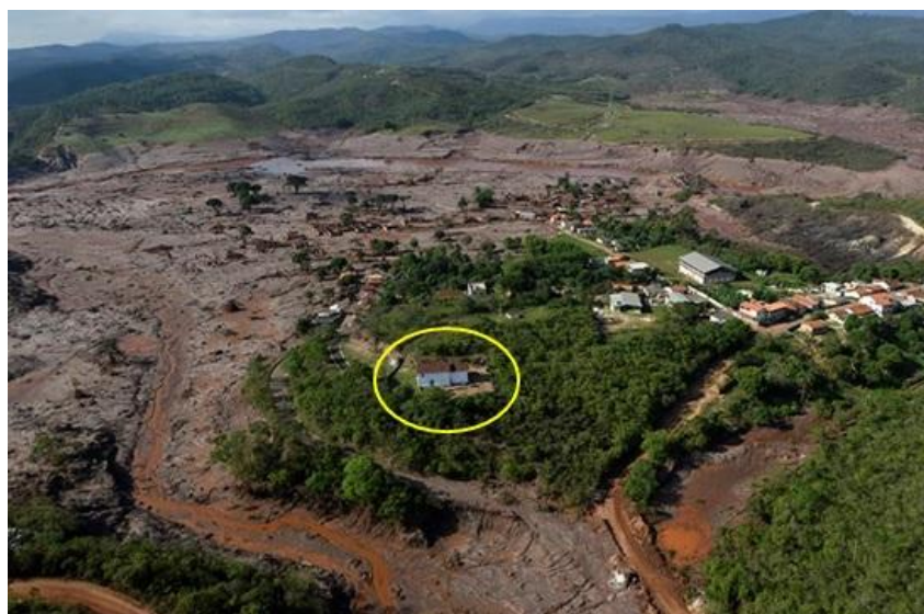
Figura 64. Município de Bento Rodrigues após rompimento da barragem do Fundão. Capela de Nossa Senhora das Mercês circulado na imagem.
