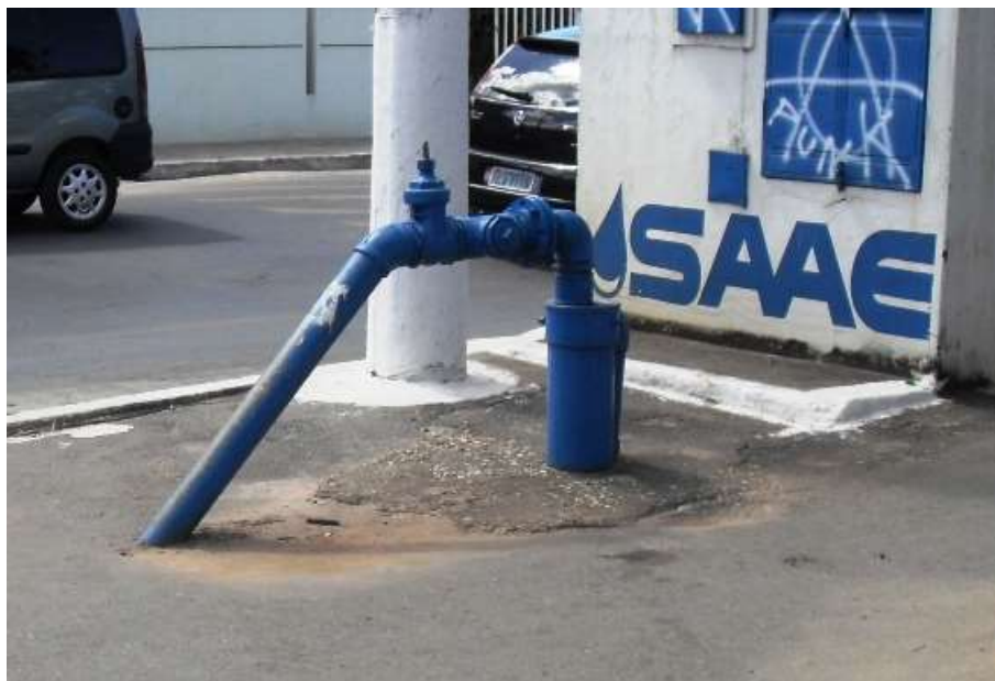
Figura 3: Poço artesiano público de extração de água localizado na área central de Sete Lagoas. (Fonte: SAAE, 2013)
