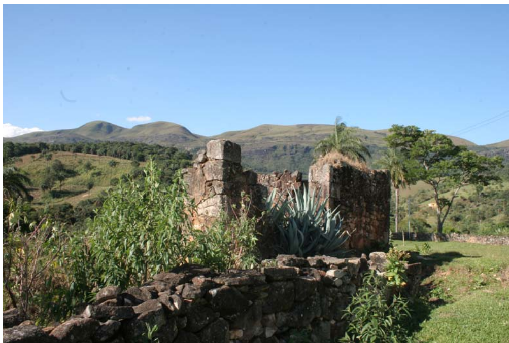
Figura 8.13 – Local onde se instalou a casa de fundição clandestina de Inácio de Souza. No primeiro plano, as ruínas e no segundo plano a Serra da Moeda
