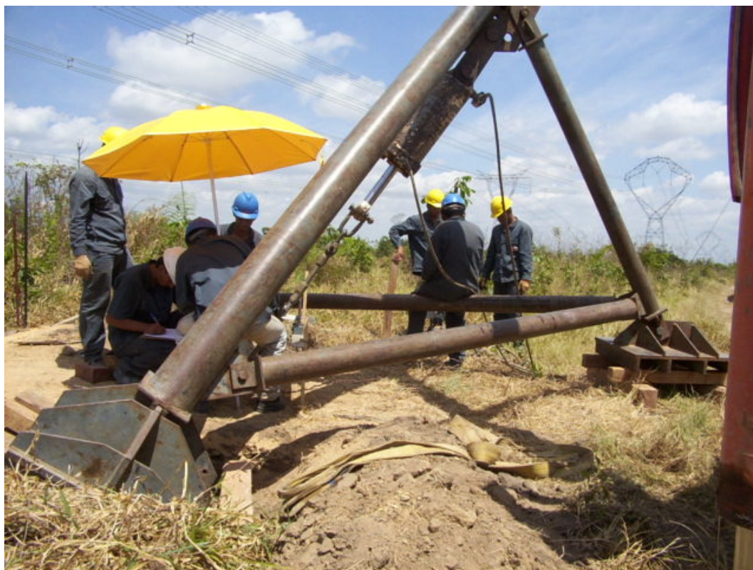
FIGURA 4.1 Ensaio de Tração em Fundação de Estai
