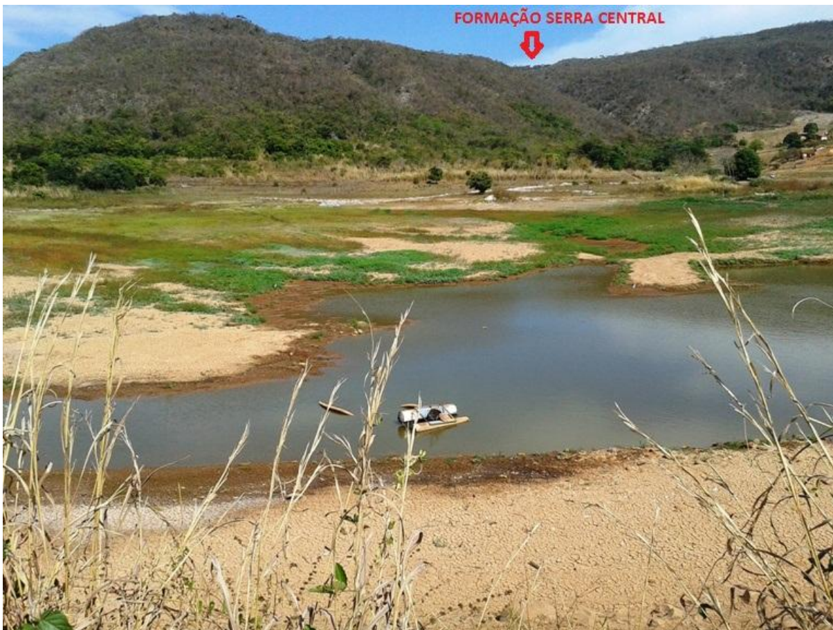
Figura 27 – Vista da crista da barragem de Mamonas para o reservatório. Ao fundo, formação Serra Central.
