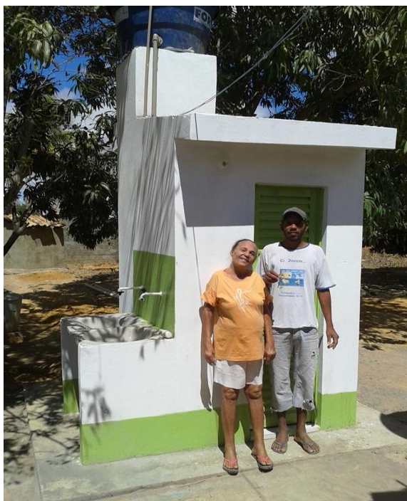
Figura 18 – Uma das famílias beneficiadas com a implantação de Módulo Sanitário, em Catuti/MG.
