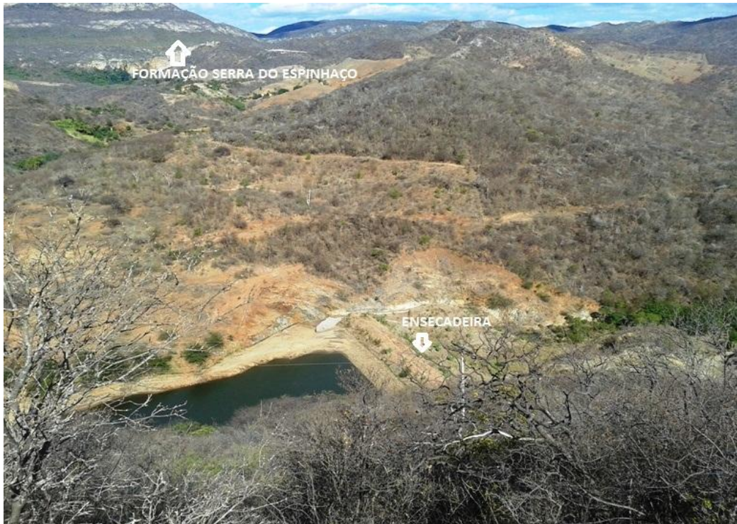
Figura 30 – Vista para o ponto de captação de água dos municípios de Mato Verde e Catuti.
