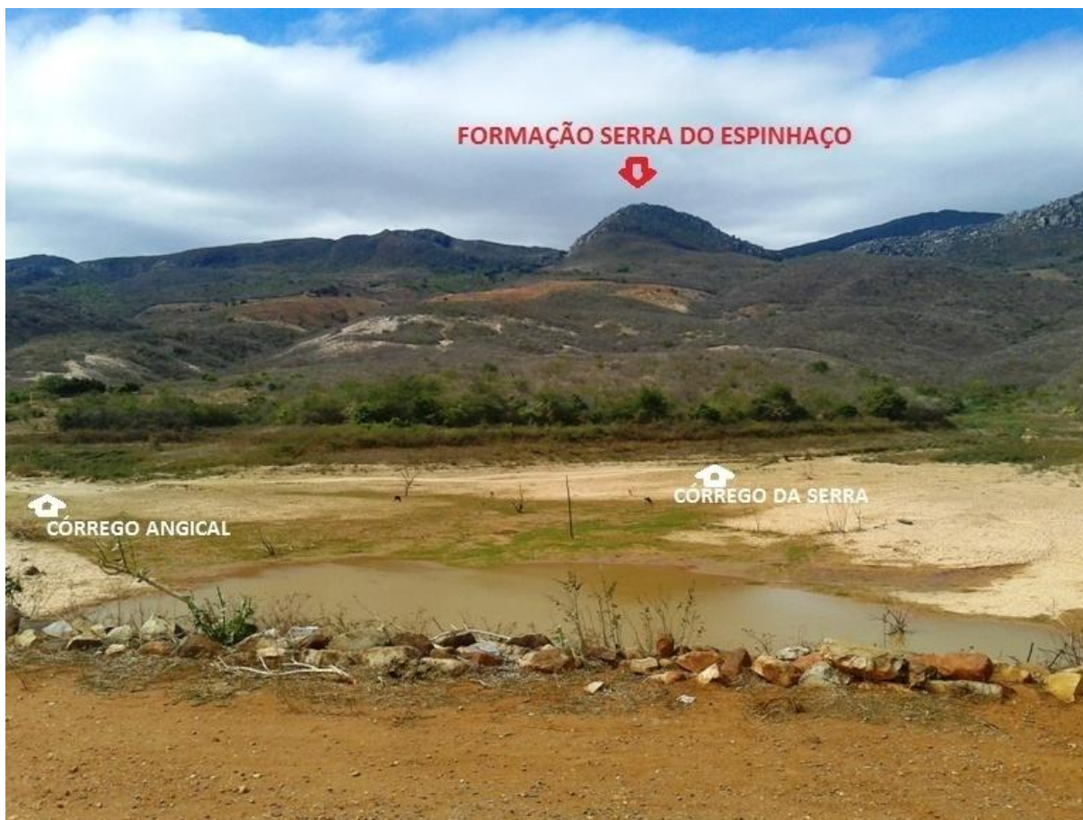
Figura 32 – Vista da crista da barragem Tremedal para o reservatório.
