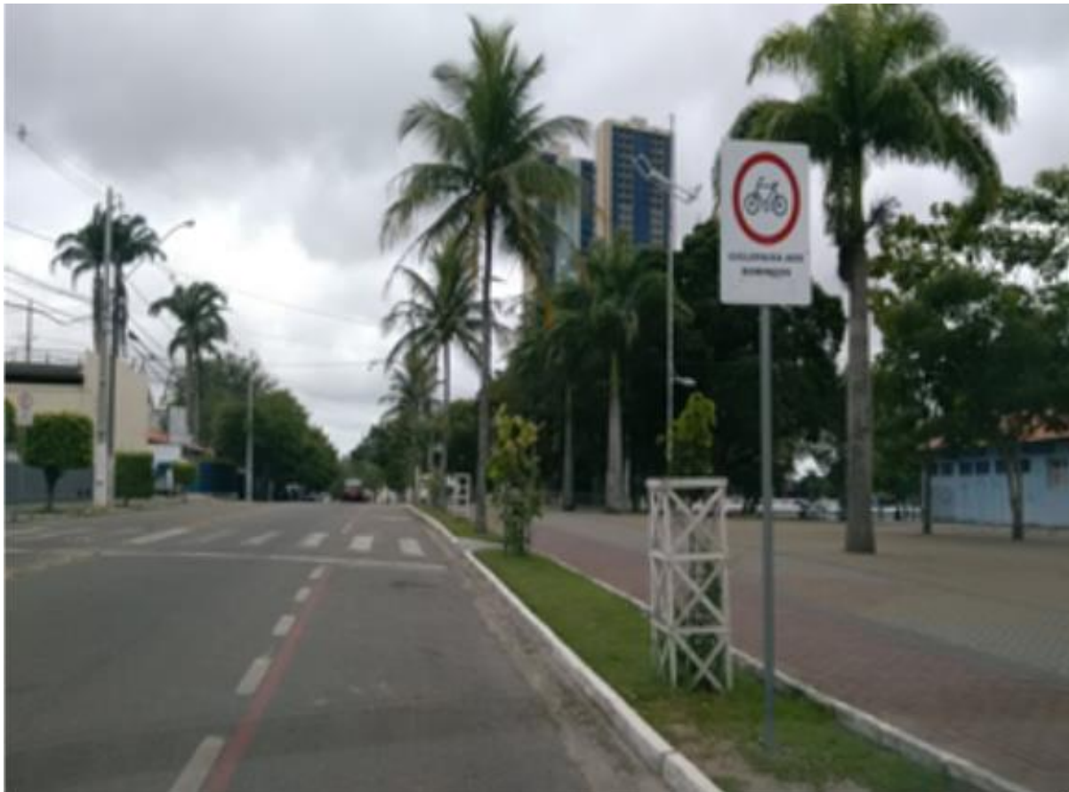
FIGURA 18 - Ciclofaixa deteriorada por meio de cor desbotada
