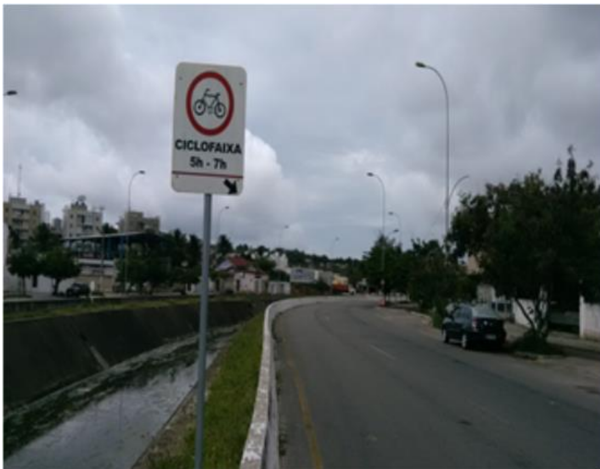
Figura 17 - Ciclofaixa deteriorada por meio de cor desbotada
