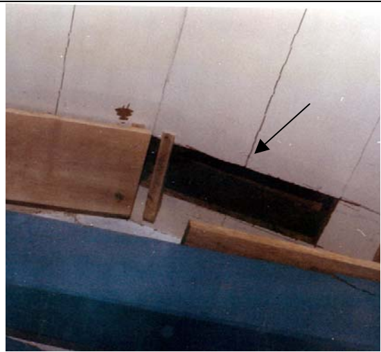
b – Colocação do arremate
