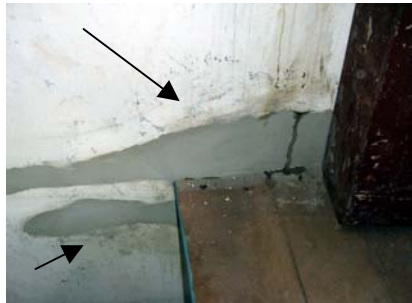
h - Intervenção na parede acima do Coro
