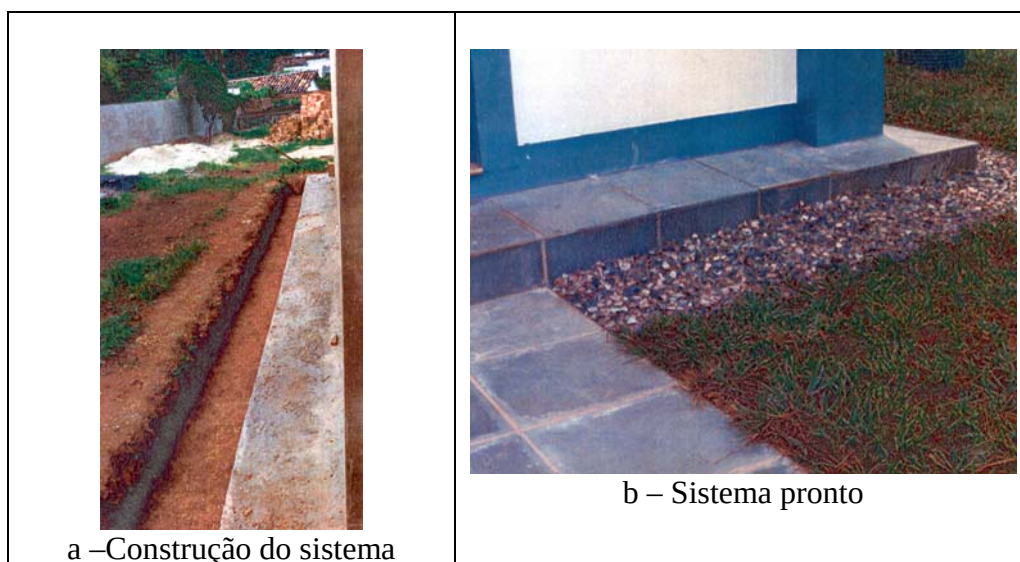
FIGURA 42 – Dutos de Drenagem (FONTE: Engearp, 1988)
