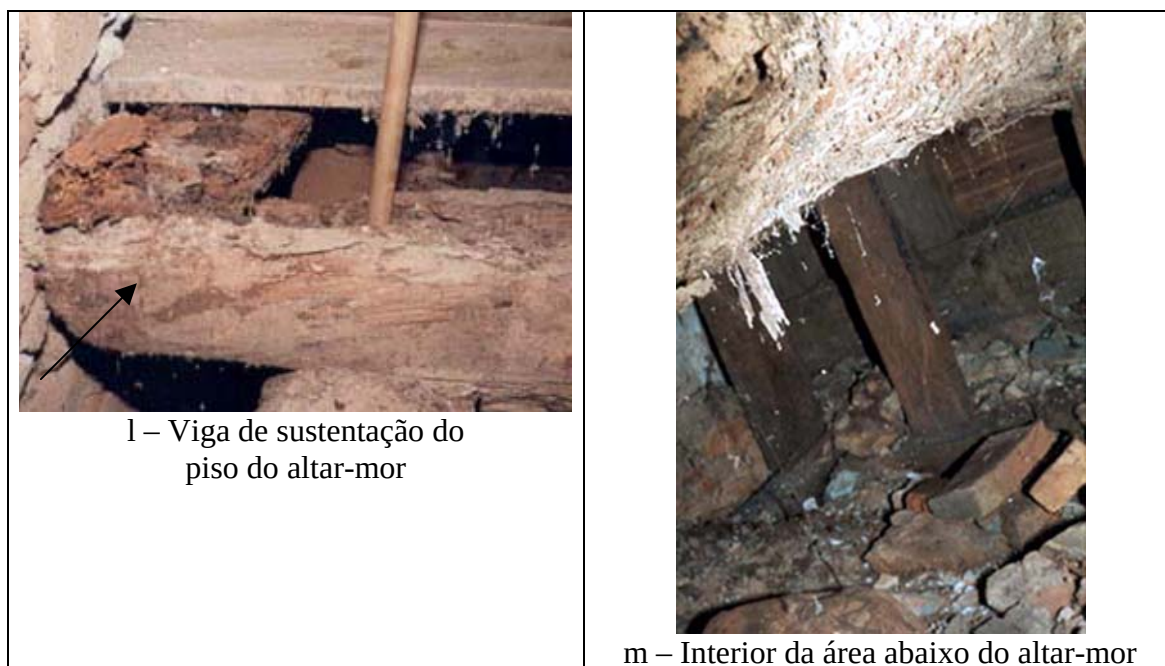
FIGURA 38 – Estado de conservação da edificação: área externa e interna
