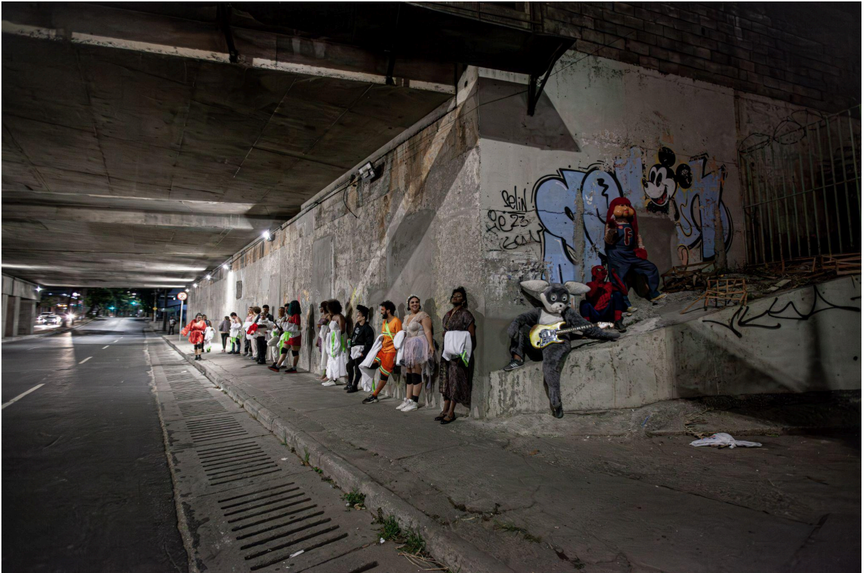
Ilustração 7 – Bagunça ocupa baixo do viaduto
