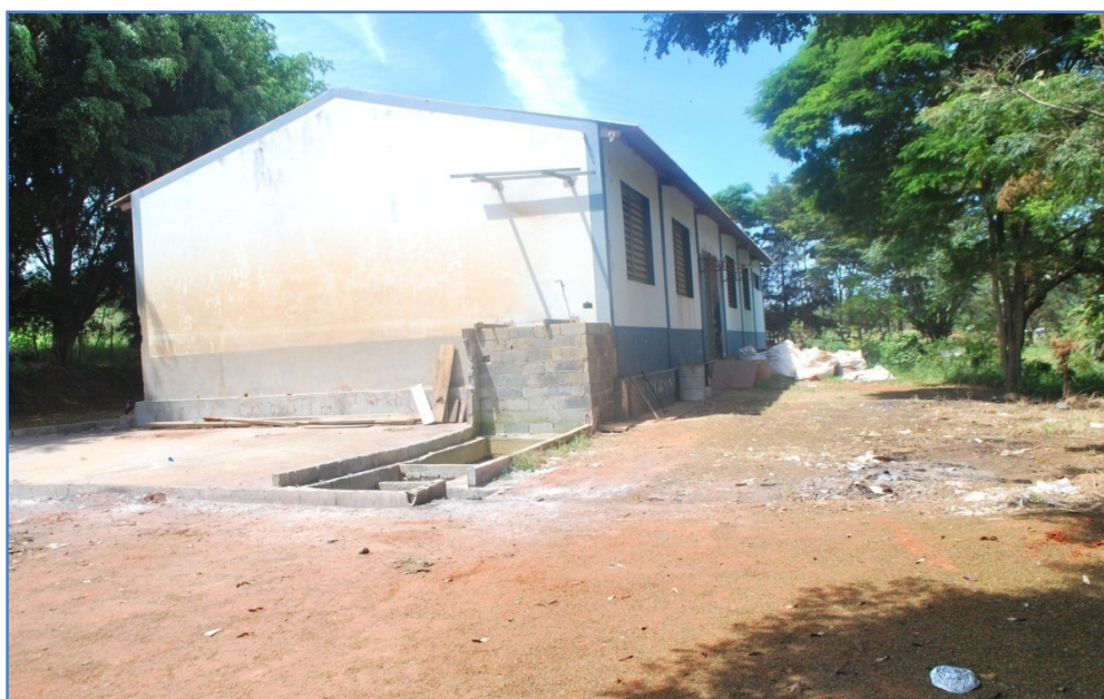
FIGURA 47 – Frente do galpão para funcionamento da separação dos resíduos sólidos Fonte: Secretaria de meio ambiente de Mateus Leme, 2009.
