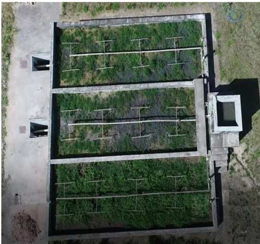
Figura 5.4 – Registro aéreo do wetland vertical – Sistema Francês experimental localizada na ETE Arrudas.
