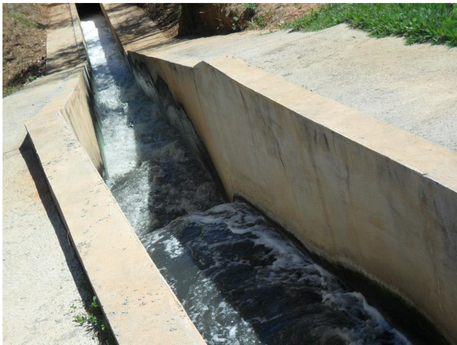
FIGURA 26 - Estrutura de lançamento de efluente tratado da ETE-VIEIRAS – Montes Claros –MG
