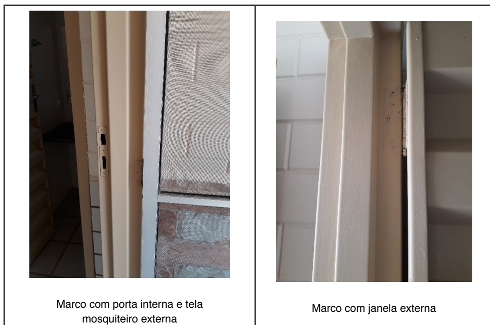
Figura 4 – Detalhe do jabre duplo em porta e janela
