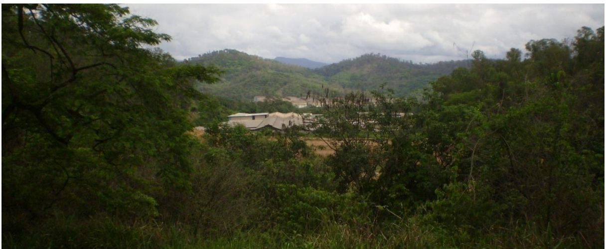
Figura 108 – Usiminas encoberta pelo cinturão verde e, ao fundo, serras do sentido norte da cidade
