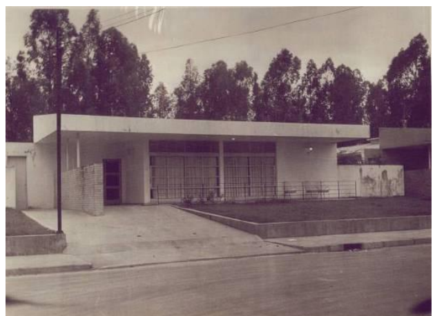
Figura 50 – Residência tipo do bairro Castelo Fonte: Acervo Técnico da Usiminas, déc. 60
