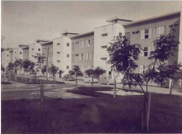
Figura 56 – Edifício multifamiliar do bairro Cariru Fonte: Acervo Técnico da USIMINAS, déc. 60.
