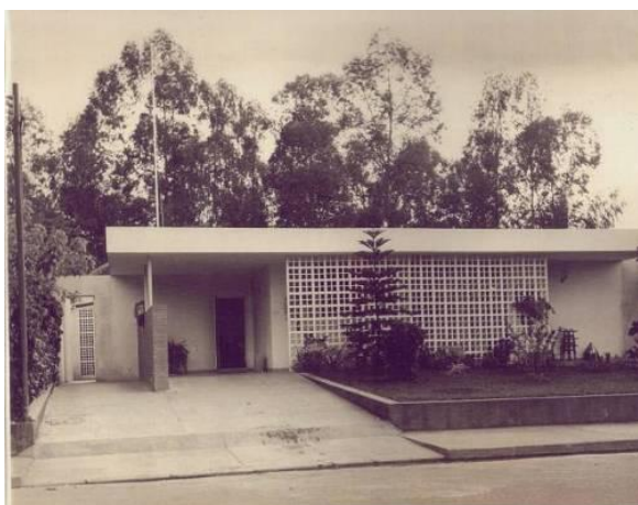
Figura 49 – Residência tipo do bairro Castelo Fonte: Acervo Técnico da Usiminas, déc. 60.
