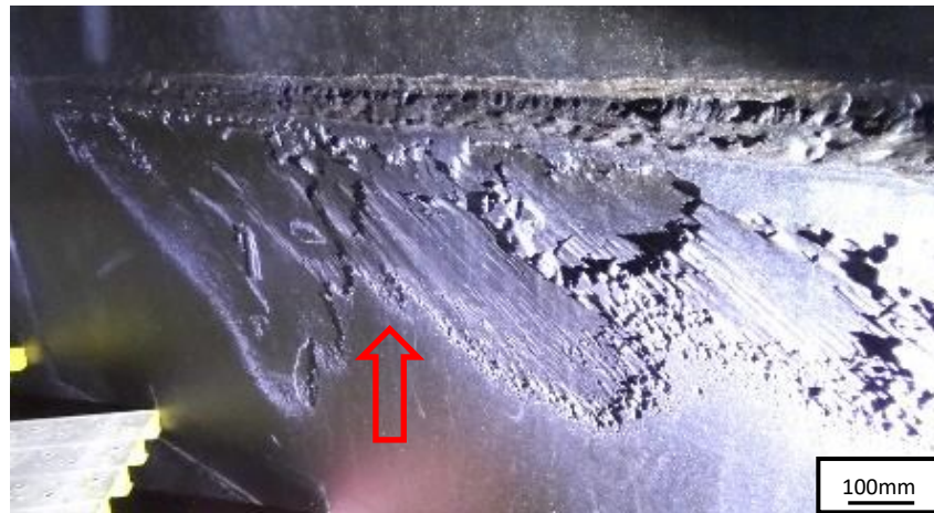
Figura 48 – Corrosão naftênica na parte inferior da torre.
