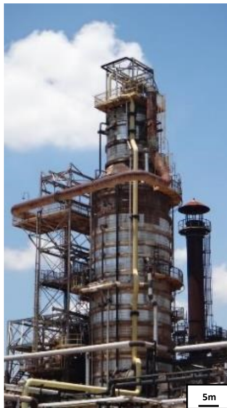
Figura 40 – Torre de destilação a vácuo. Fonte: PETROBRAS, 2022.
