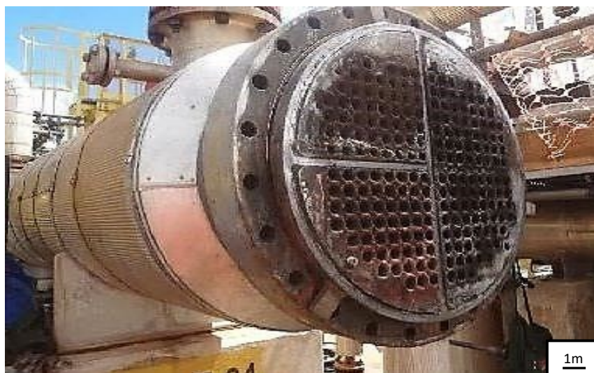
Figura 9 – Sais de bissulfeto de amônio no espelho do trocador de calor. Fonte: PETROBRAS, 2019.
