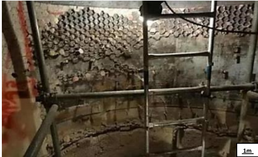
Figura 24 – Exposição das malhas metálicas hexagonais. Fonte: PETROBRAS, 2022.
