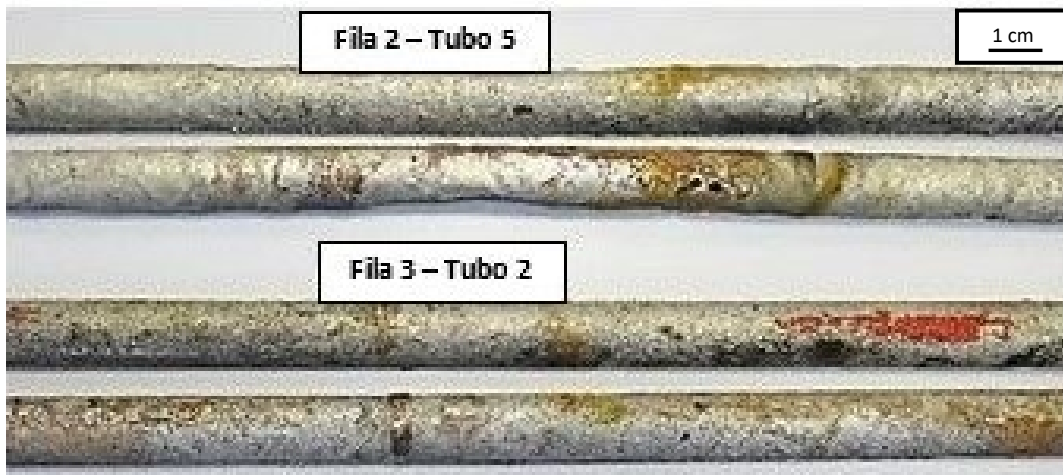
Figura 35 – Região externa dos tubos do trocador de calor. Fonte: PETROBRAS, 2020.
