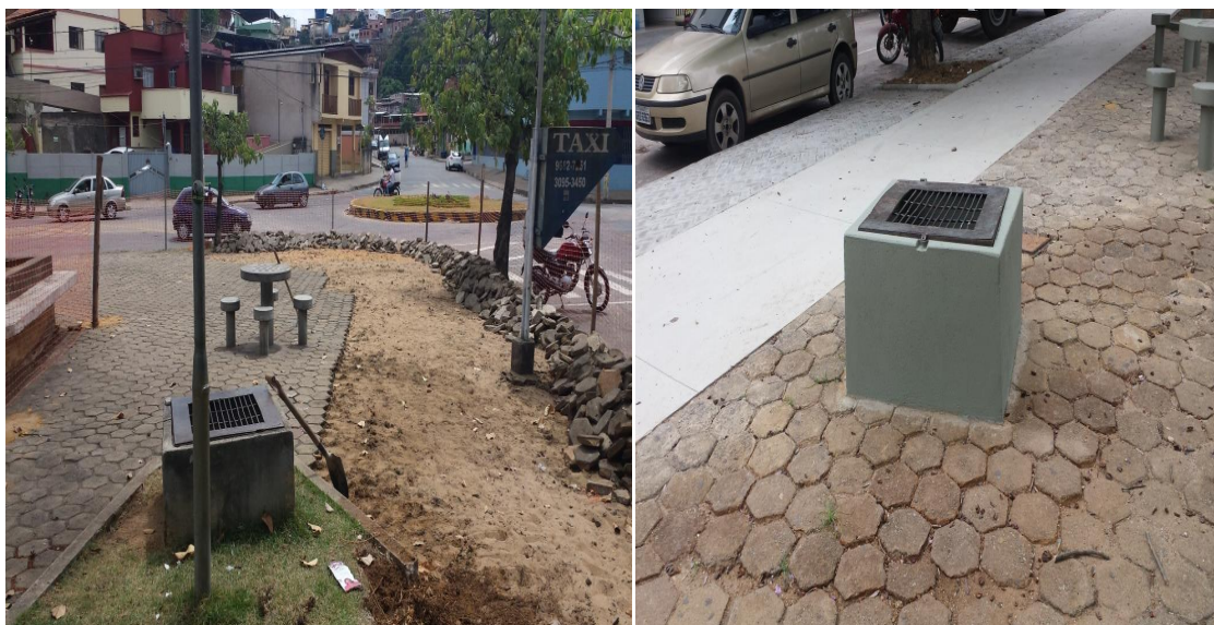
Figura 7 - Construção da pista de caminhada na Praça do Canaãzinho.
