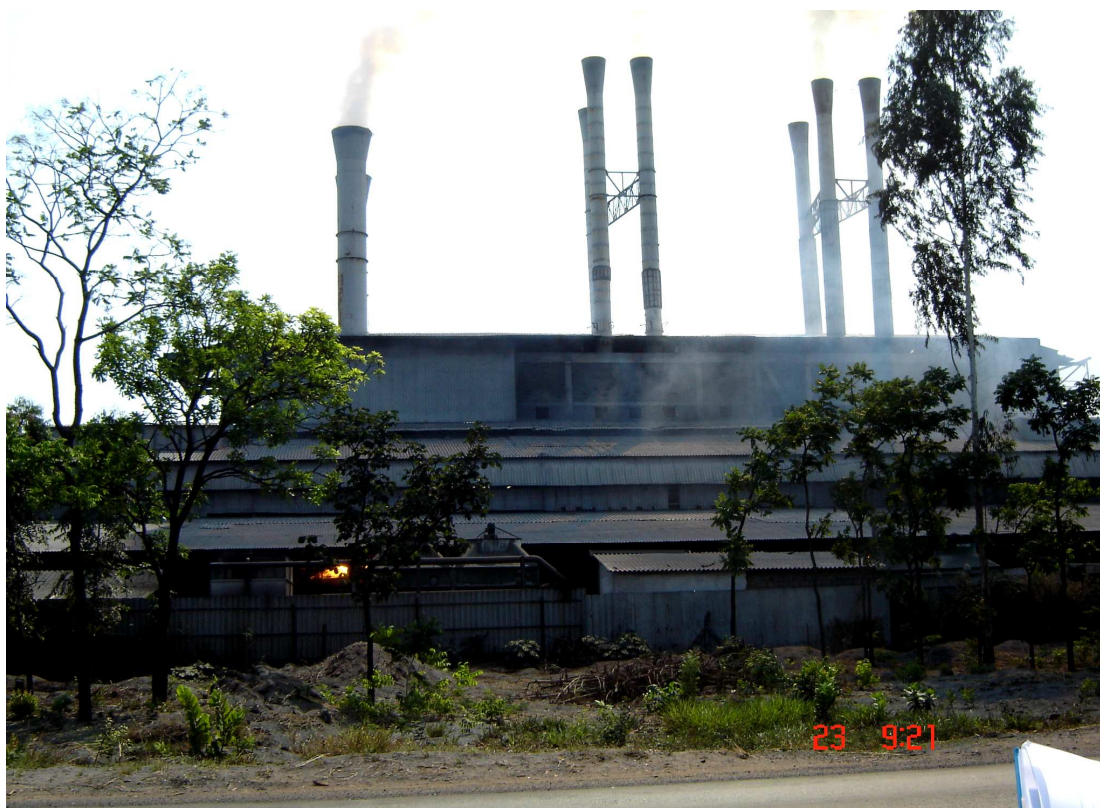
Figura 1.1 – Usina para produção de silício e ferro-ligas. São visíveis os fornos de fusão elétrica, as chaminés e aparelhos para resfriamento e lavagem do gás liberado. Foto tirada da BR-496 na direção leste.
