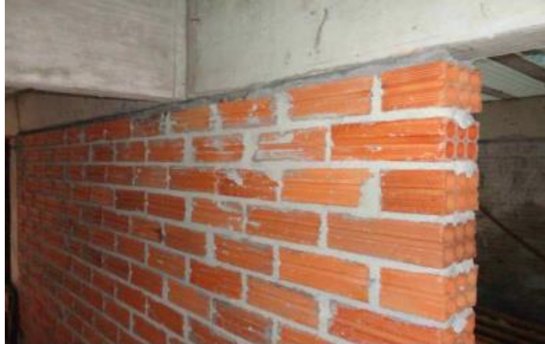
Figura 5.14: Execução de encunhamento com argamassa expansiva
