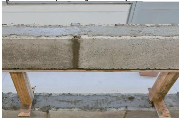
Figura 5.13: Execução de verga com utilização de escoramento
