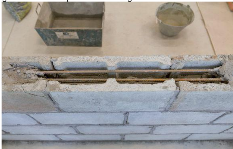
Figura 5.12: Execução de contraverga com uso de blocos canaleta
