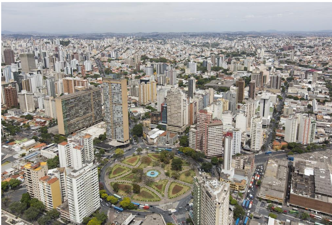
Imagen 23: Plaza Raul Soares - Visión panorámica en la que se observa al fondo la Sierra del Curral. Autor: Marcos Desimoni, Obras de Movilidad urbana Belo Horizonte, 2012.
