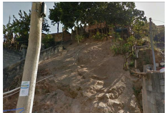
Fig.4 – Edificação da quadra1, No.135 foi indicada pelo algoritmo propensa ao risco
