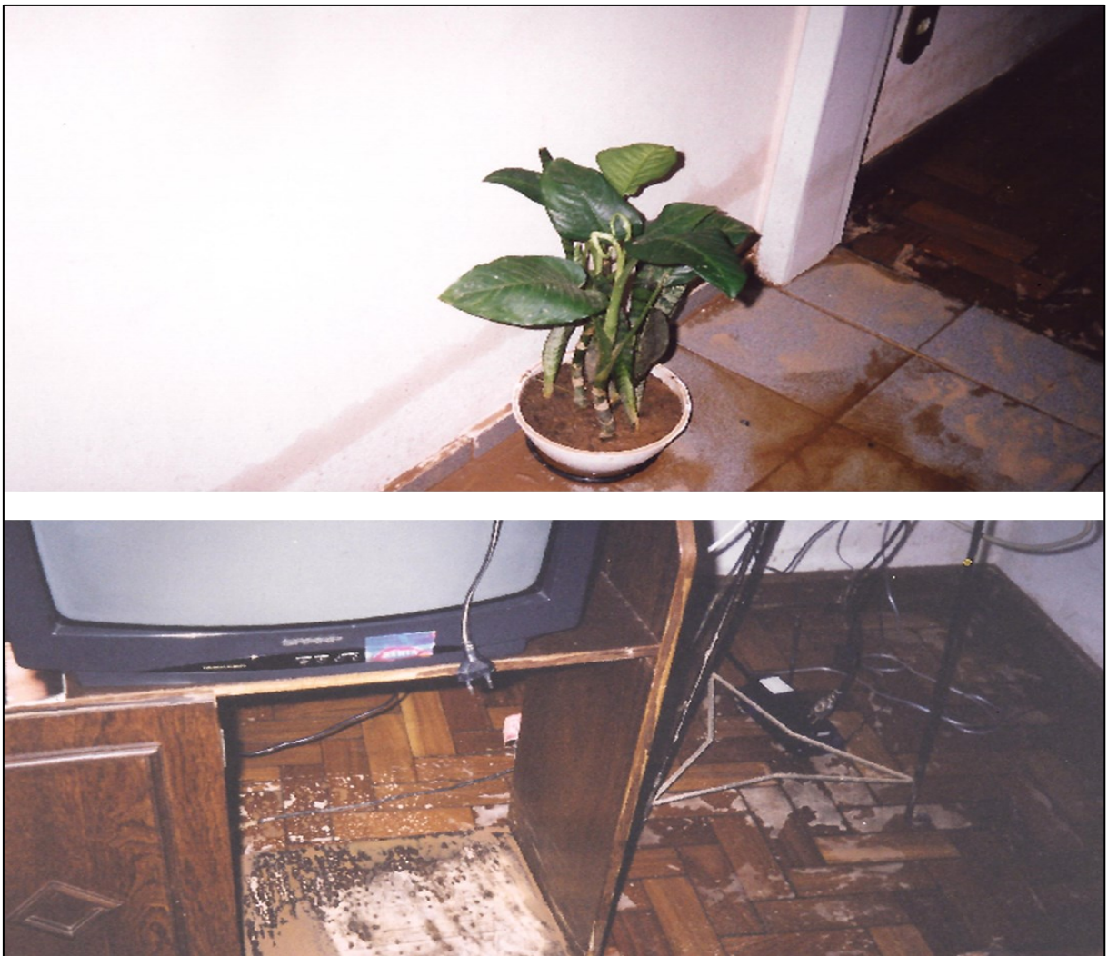
Figura 4.8 - Aspecto dos revestimentos de piso após inundação em novembro de 2010 – Av. Tereza Cristina, Belo Horizonte - MG.
