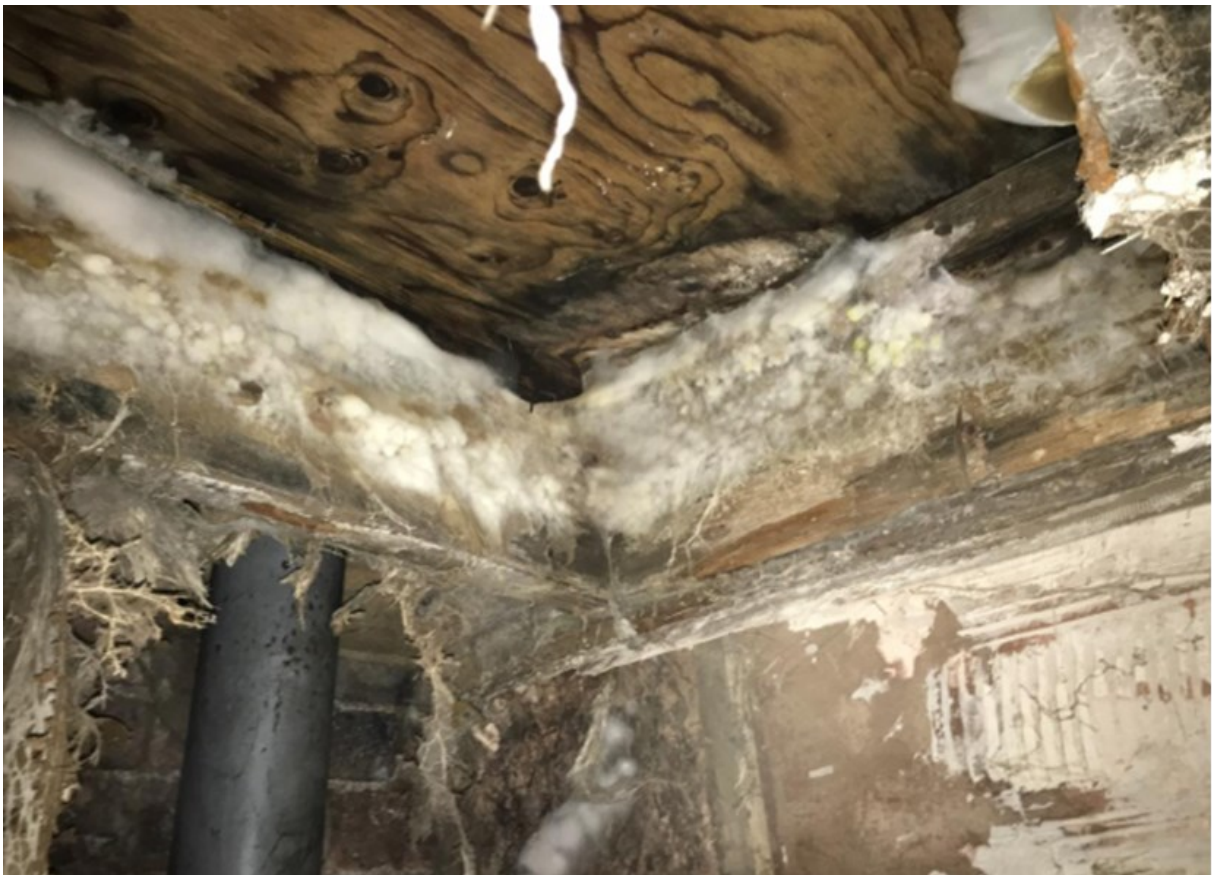
Figura 3.10 - Infestação em madeira por Serpula lacrymans .
