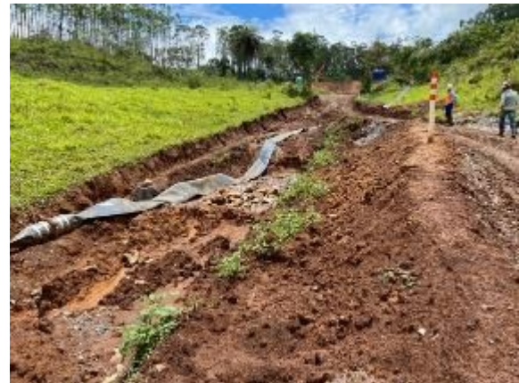
Figura 9 - Acesso poço 03, vista sentido baixo para cima.
