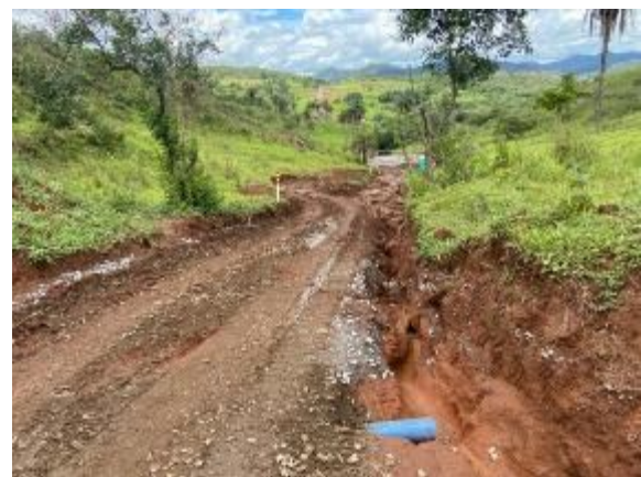
Figura 13 - Extravasor Sump Poço 03.
