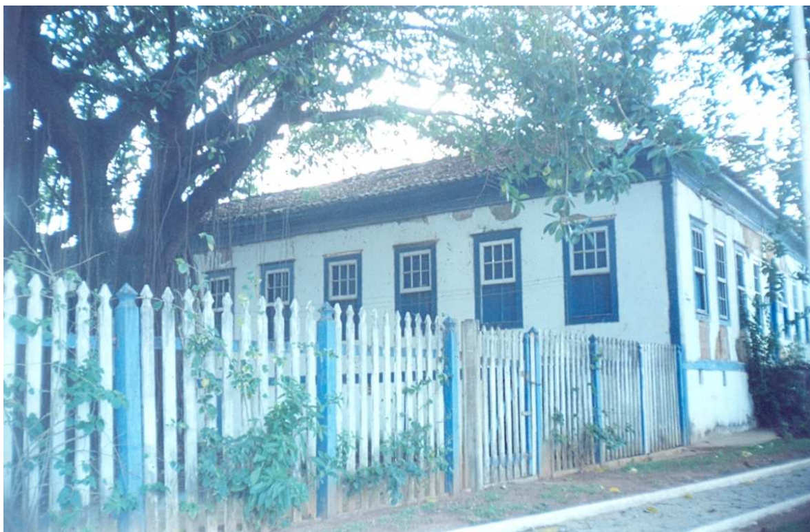
FOTO 2 – O Casarão ou Museu . Local que, abandonado pelo poder público, foi utilizado para as reuniões que visavam à fundação do Sindicato dos Trabalhadores Rurais de Lagoa da Prata/MG. Fonte: Arquivo pessoal.
