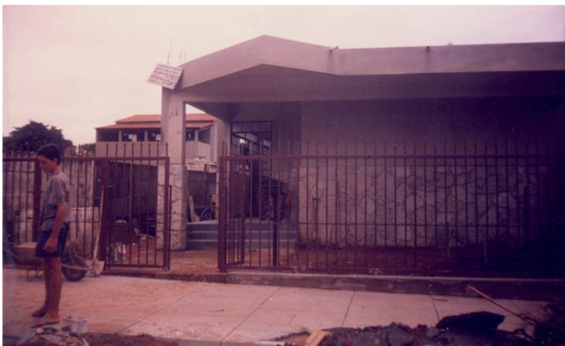
FOTO 6 – Os alicerces da independência . Retrato da obra de construção da sede própria do sindicato. A transformação exercida e vivida pelos trabalhadores através da luta coletiva concretiza-se no espaço da cidade, que contém e revela a história concreta. Fonte: Arquivo pessoal.
